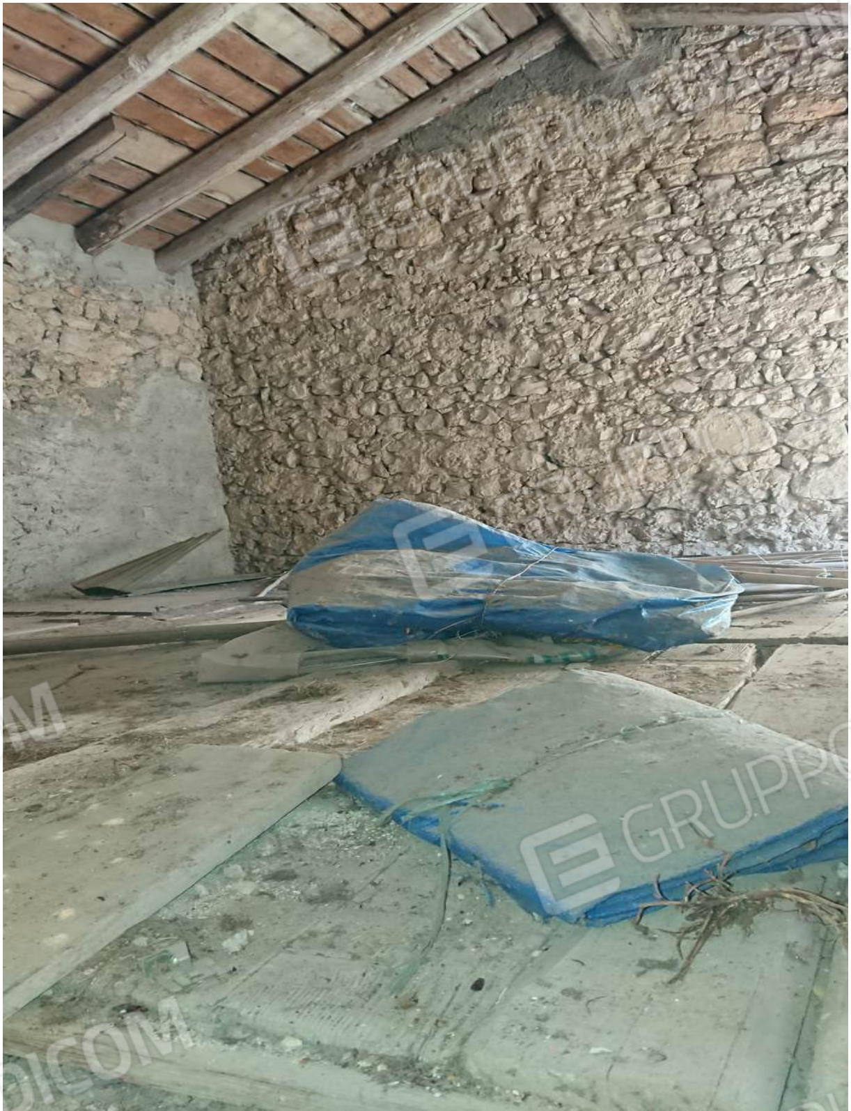
Foto n° 27 - 18/01/2022 - Comune di Caneva, foglio 21, part.159 – Piano primo.
