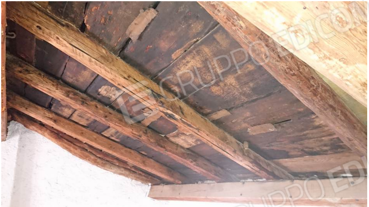
Foto n° 21 - 18/01/2022 - Comune di Caneva, foglio 21, part.156-157 – Particolare del tetto di copertura.
