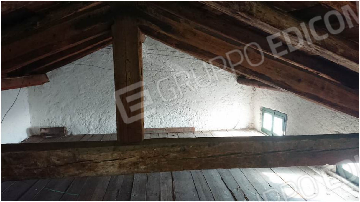
Foto n° 19 - 18/01/2022 - Comune di Caneva, foglio 21, part.156-157 – Sottotetto.
