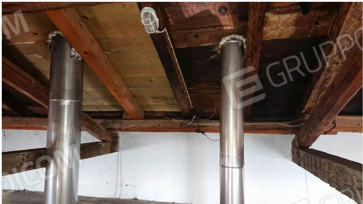
Foto n° 20 - 18/01/2022 - Comune di Caneva, foglio 21, part.156-157 – Sottotetto.
