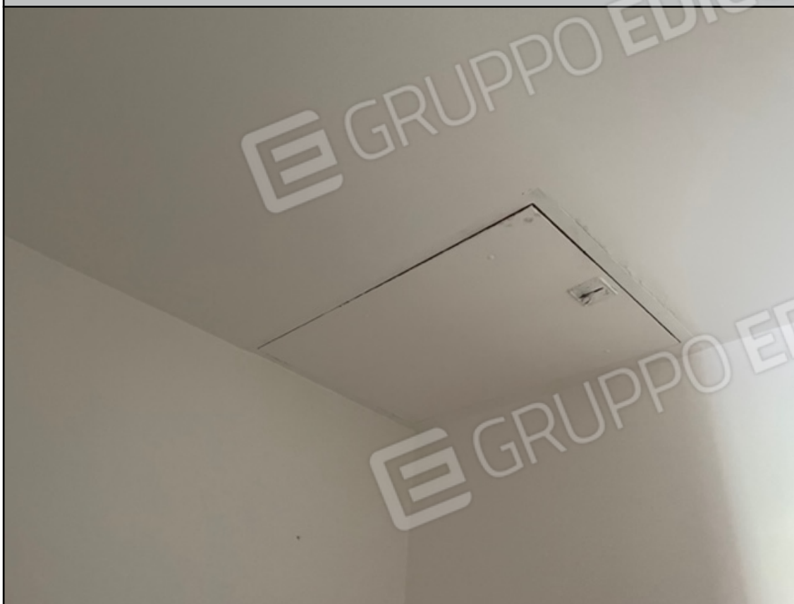
Botola per accesso a soffitta
