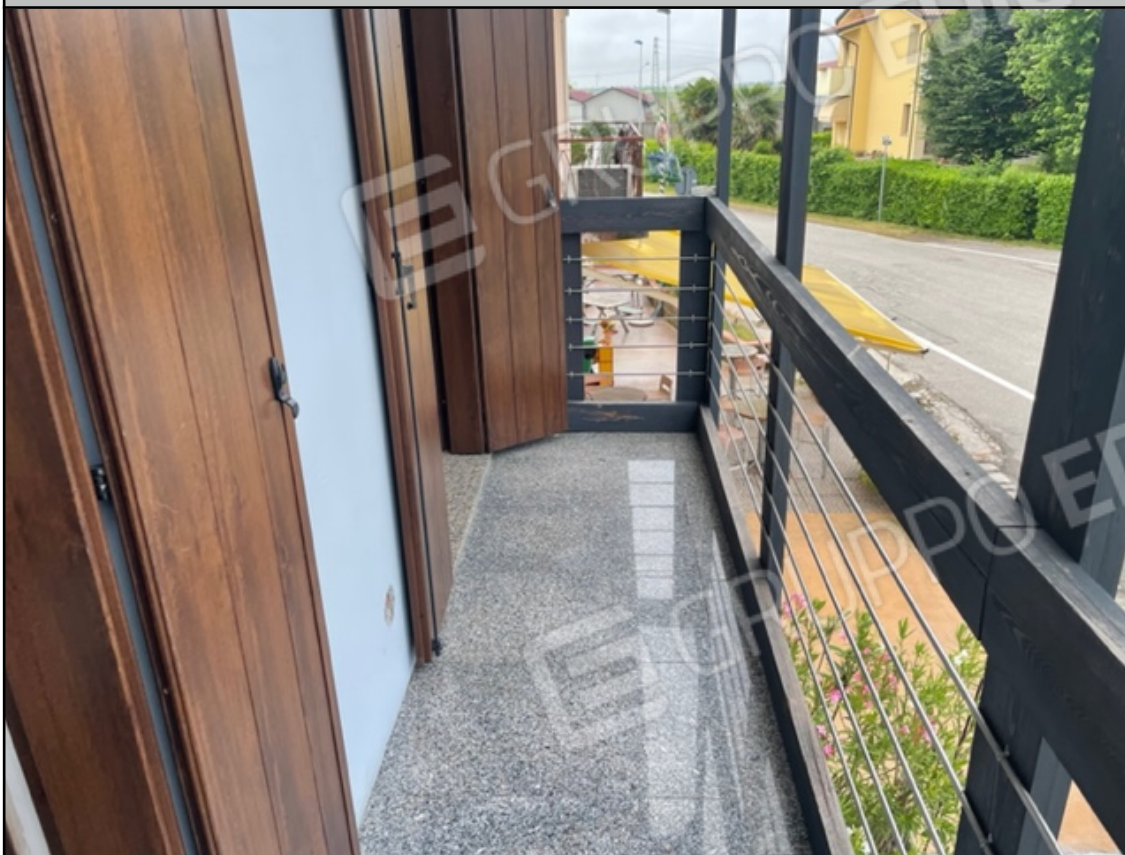
Balcone esterno, lato strada
