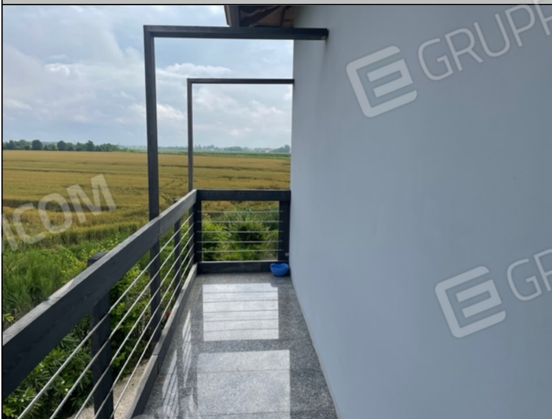
Balcone esterno, lato nord
