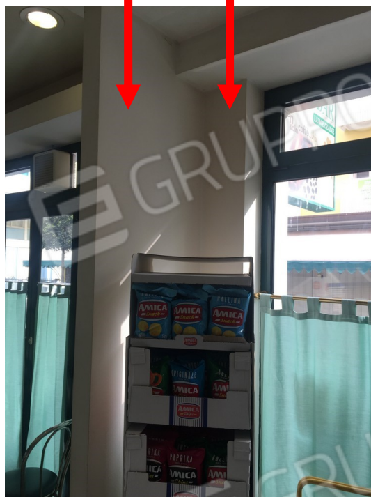
difformità catastale e di progetto dei pilastri e di una parete in prossimità alle vetrate dell'immobile commerciale
