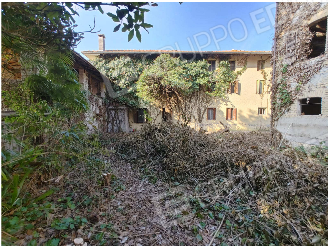
Foto 5 – Vista lato ovest – fabbricato confinante
