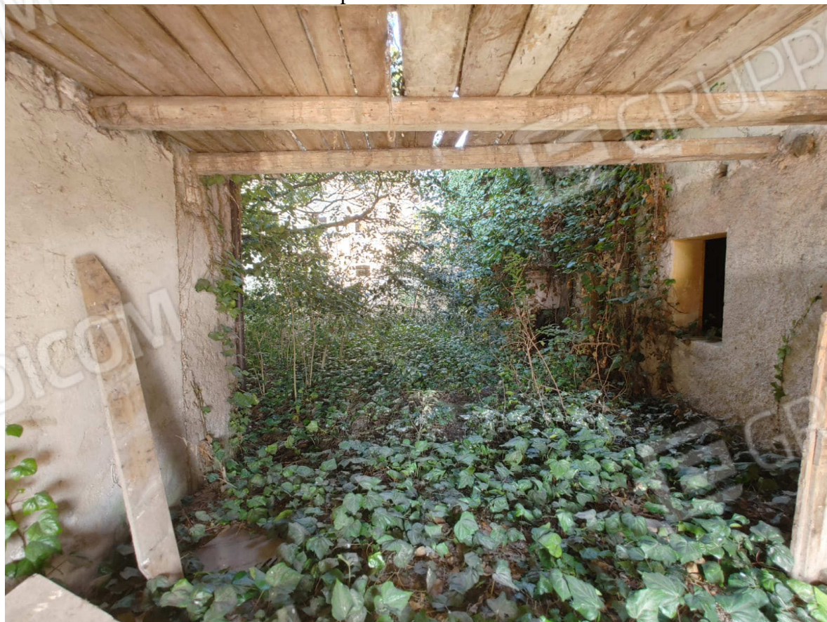
Foto 12 – Vista portico di entrata da Via Castions
