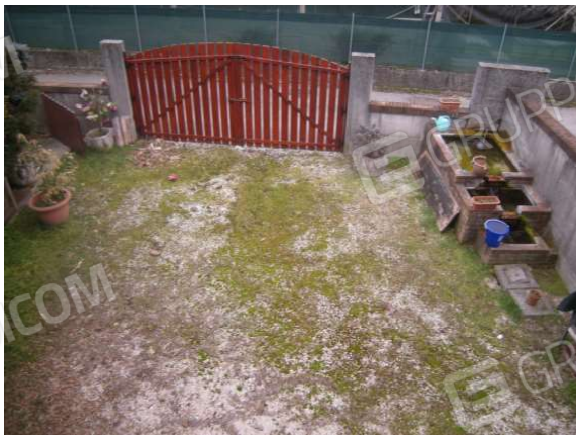
San Vito al Tagliamento, via Oberdan n. 84, piano terra – L'ingresso carraio all'immobile.
