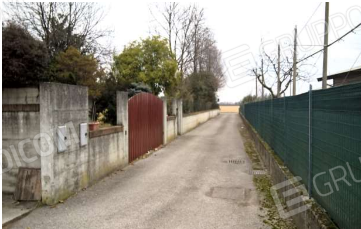
San Vito al Tagliamento, via Oberdan n. 84 – Il prospetto a sud -ovest dell'edificio.
