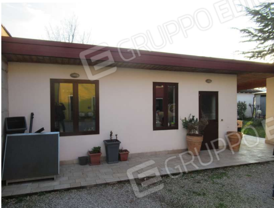
Foto 22: Prospetto Nord accessorio
