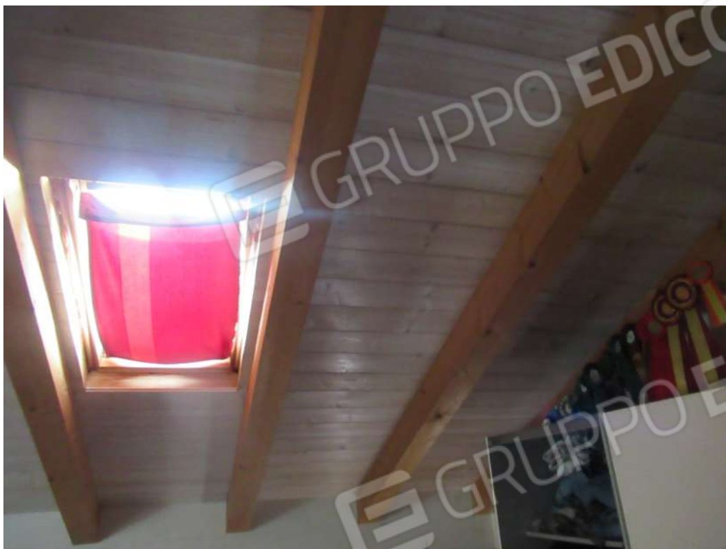
Foto 21: Finestra nel tetto
