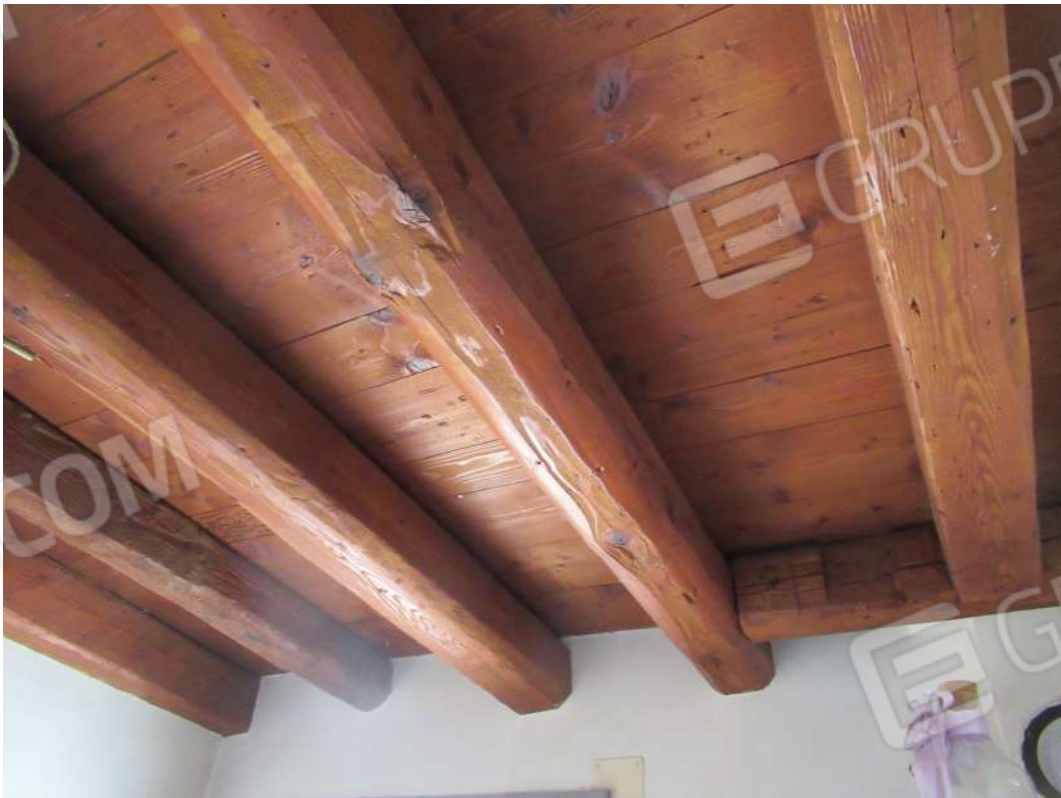
Foto 8: Soffitto Piano Terra
