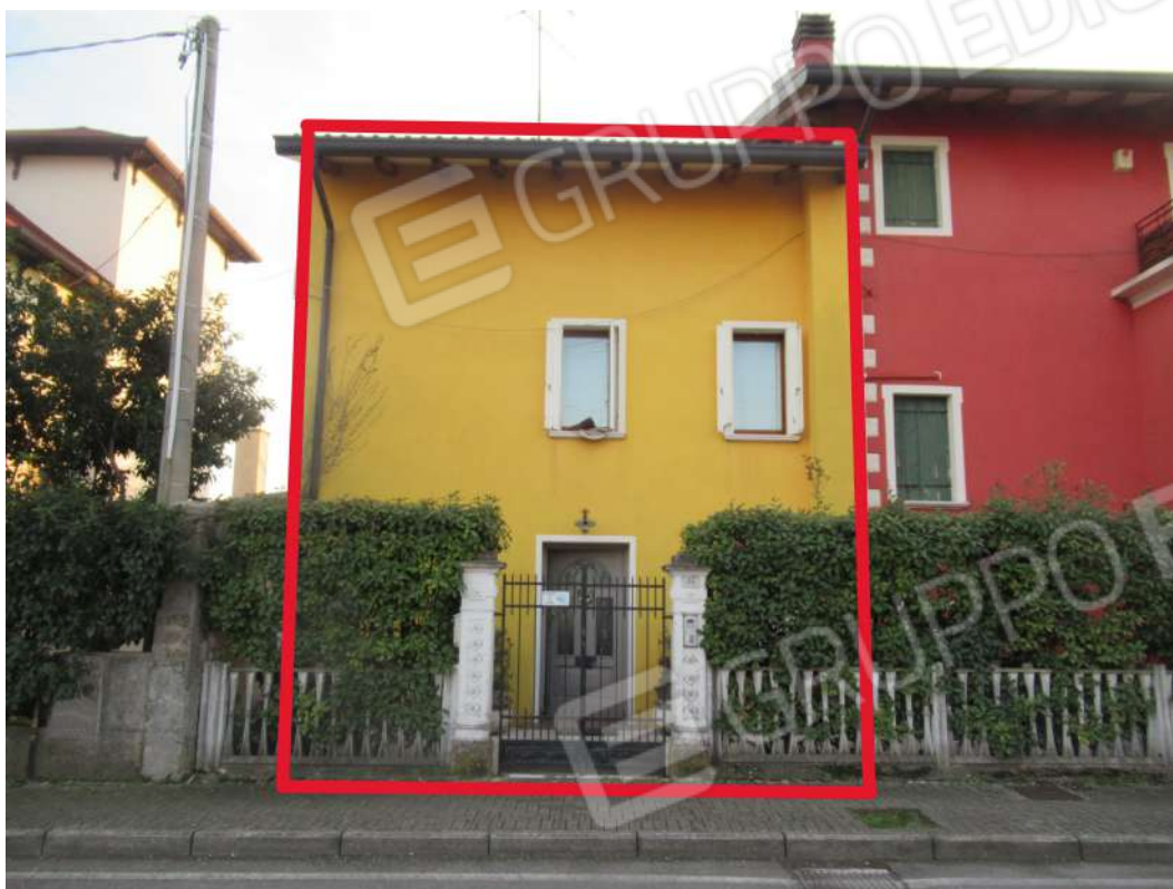
Foto 1: Vista Prospetto Nord
