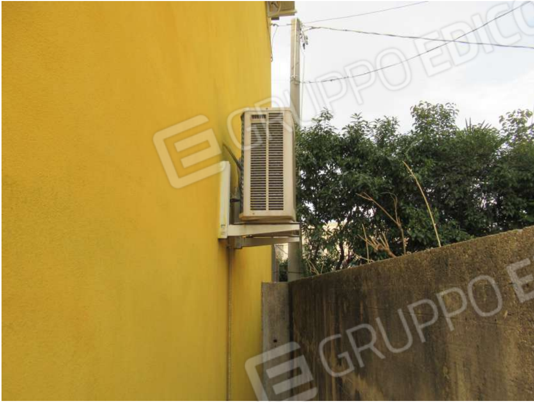
Foto 3: Vista parete Est
