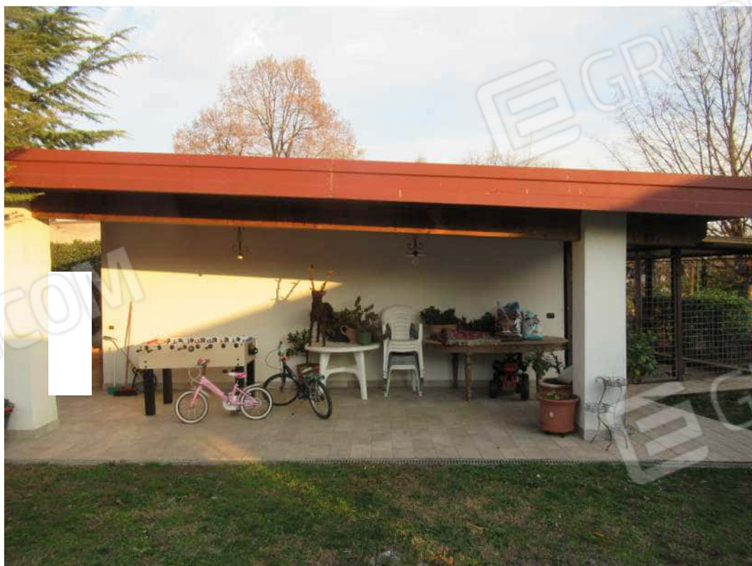
Foto 23: Prospetto Ovest portico
