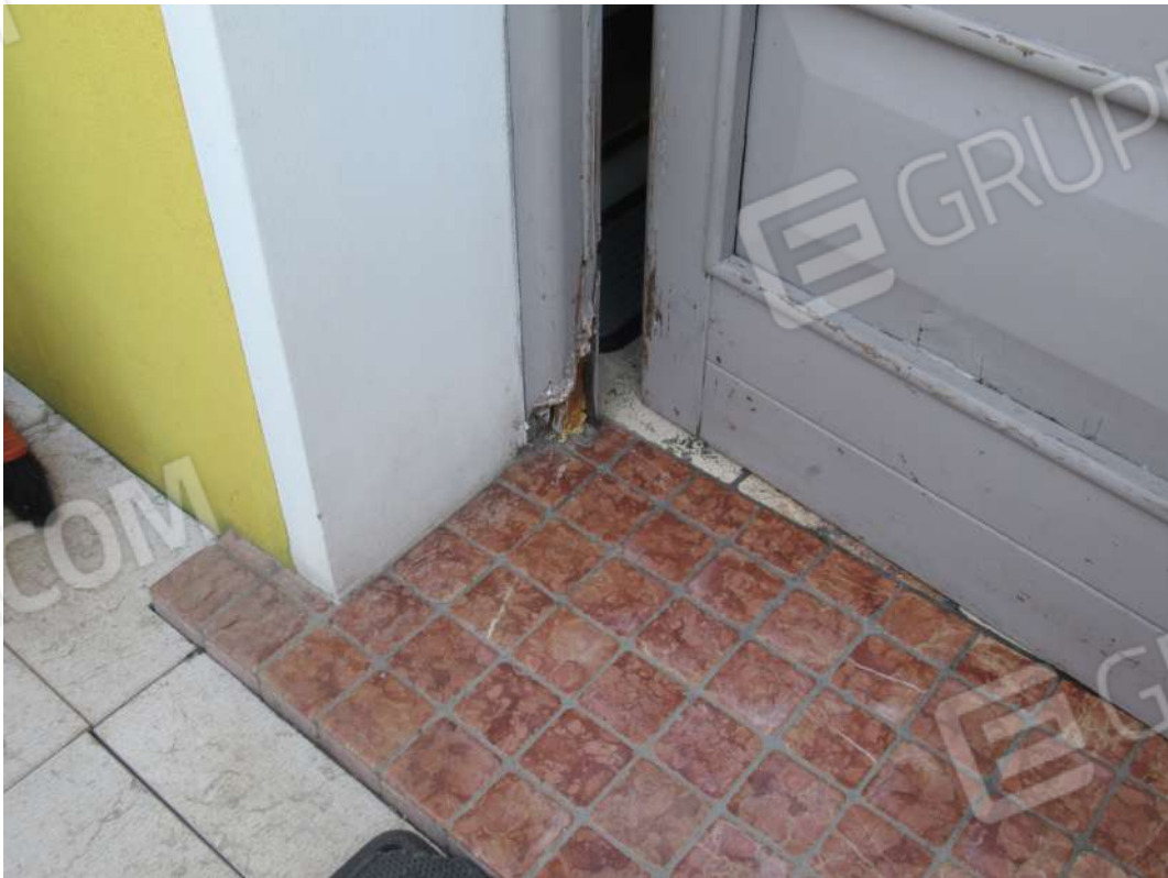
Foto 20: Particolare portoncino d'ingresso
