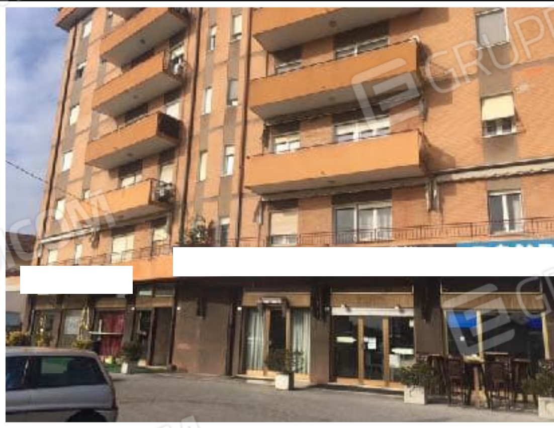
Vista piano terreno condominio Brentella
