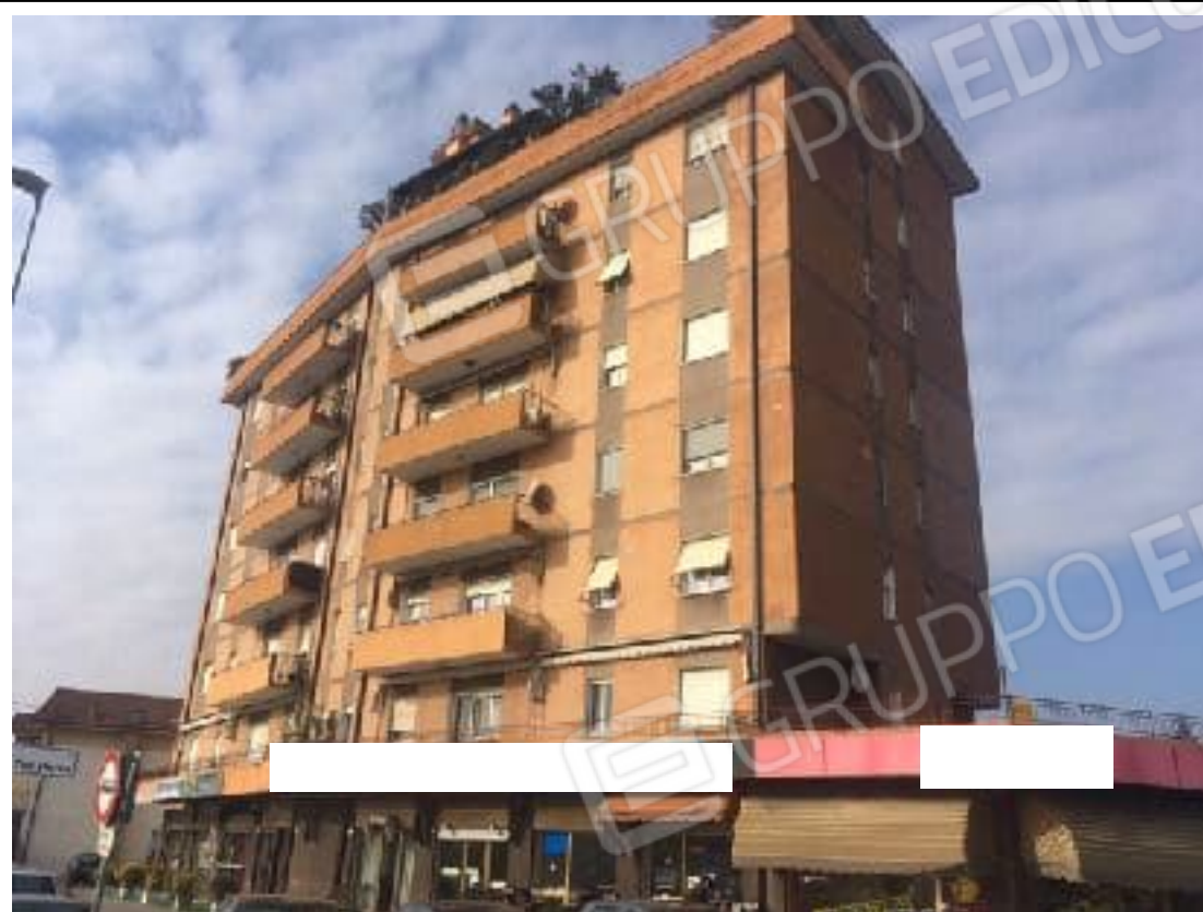
Vista esterna condominio Brentella
