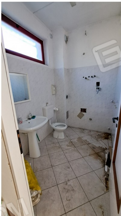
20 - bagno piano terra
