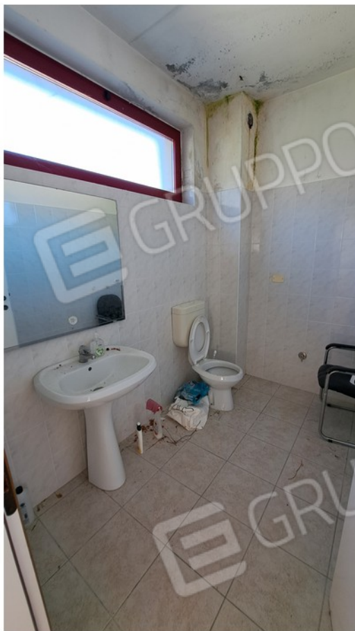
37 - bagno piano primo
