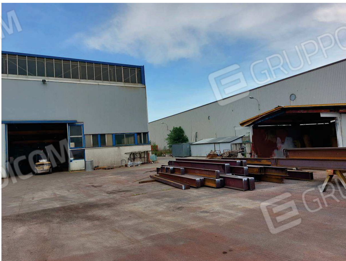
Foto n° 8 – Lotto 1 - Comune di San Vito al Tagliamento (PN) – Foglio 3 mappale 1478 – Zona Industriale Ponterosso – Via Pescopagano n°3. Veduta del capannone industriale e di parte del piazzale di pertinenza in zona nord.
