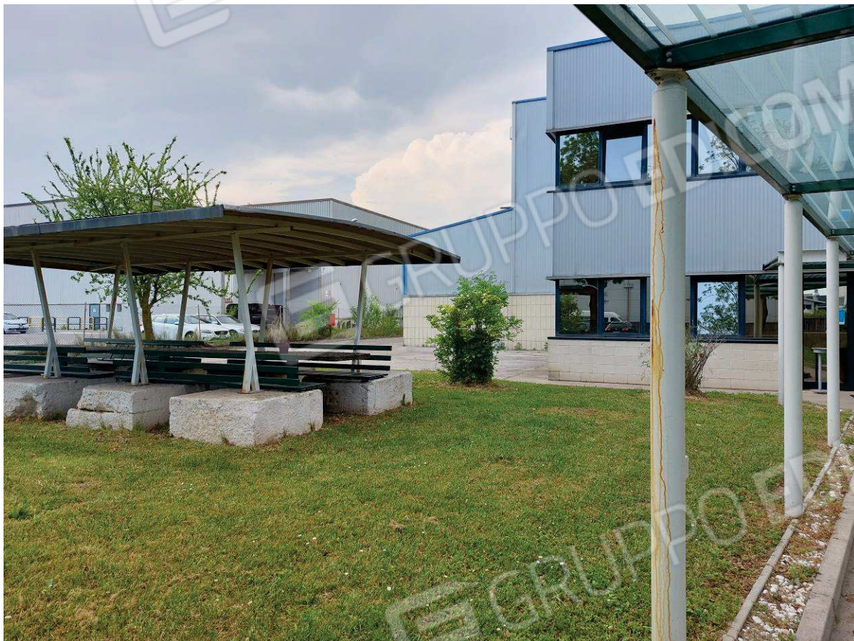
Foto n° 3 – Lotto 1 - Comune di San Vito al Tagliamento (PN) – Foglio 3 mappale 1478 – Zona Industriale Ponterosso – Via Pescopagano n°3. Veduta della parte sud-ovest dell'area verde, con spazio ricreativo presente sul lato sud-ovest della particella pignorata.
