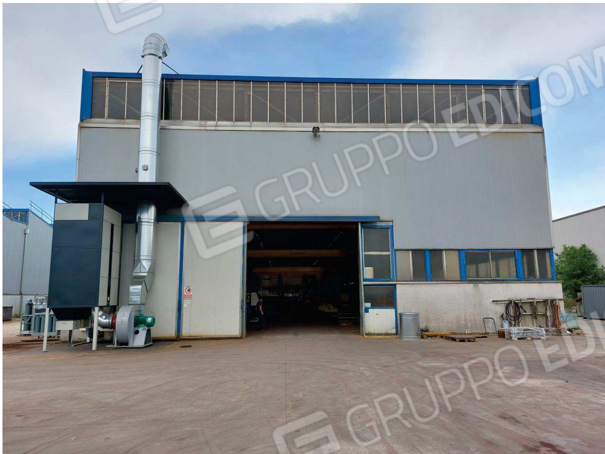
Foto n° 9 – Lotto 1 - Comune di San Vito al Tagliamento (PN) – Foglio 3 mappale 1478 – Zona Industriale Ponterosso – Via Pescopagano n°3. Particolare dell'ingresso posto sul lato nord dell'opificio.
