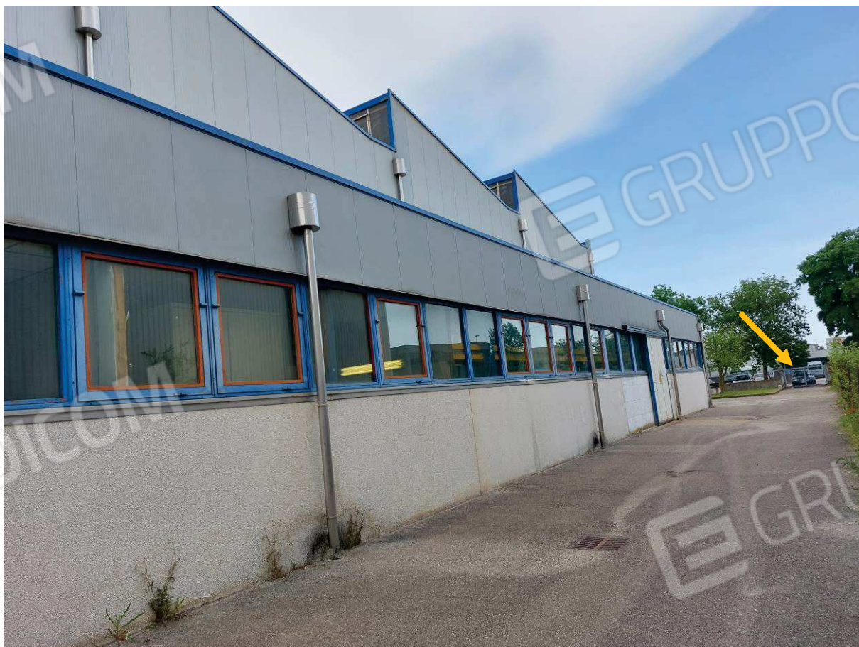
Foto n° 12 – Lotto 1 - Comune di San Vito al Tagliamento (PN) – Foglio 3 mappale 1478 – Zona Industriale Ponterosso – Via Pescopagano n°3. Particolare del prospetto ovest da posizione nord; sullo sfondo a destra nella foto si nota il cancello del passo carraio per ingresso operai (indicato da freccia arancione).
