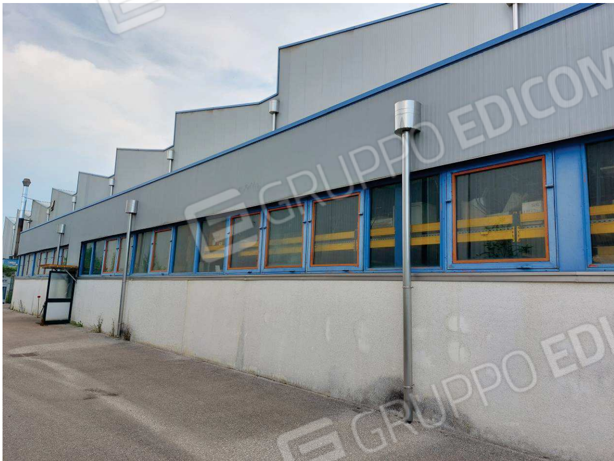
Foto n° 11 – Lotto 1 - Comune di San Vito al Tagliamento (PN) – Foglio 3 mappale 1478 – Zona Industriale Ponterosso – Via Pescopagano n°3. Particolare della facciata ovest nella parte centrale dell'edificio. A sinistra nella foto si nota la porta d'uscita dal locale uso mensa.
