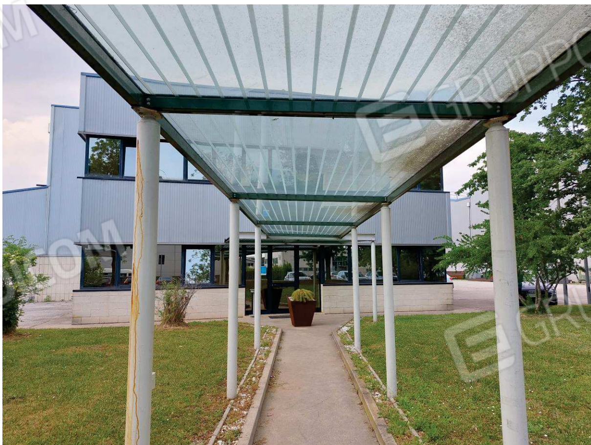
Foto n° 2 – Lotto 1 - Comune di San Vito al Tagliamento (PN) – Foglio 3 mappale 1478 – Zona Industriale Ponterosso – Via Pescopagano n°3. Particolare del passaggio pedonale con tettoia, che conduce all'ingresso degli uffici.
