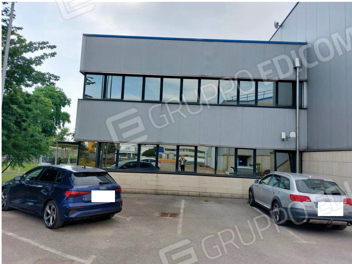
Foto n° 5 – Lotto 1 - Comune di San Vito al Tagliamento (PN) – Foglio 3 mappale 1478 – Zona Industriale Ponterosso – Via Pescopagano n°3. Particolare della facciata est nella parte destinata ad uffici, con parcheggi esterni.
