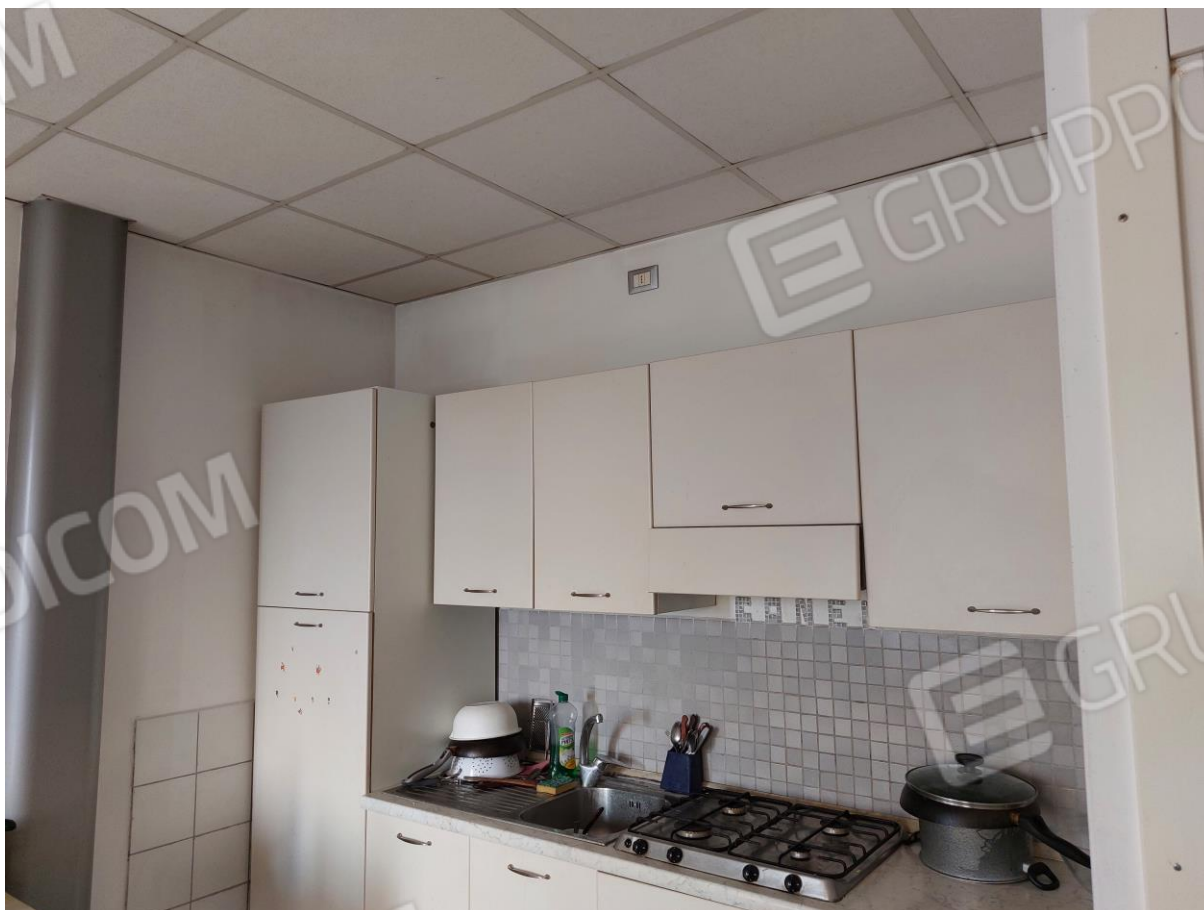
Foto n° 40 - Lotto 1 - Comune di San Vito al Tagliamento (PN) - Foglio 3 mappale 1478 - Zona Industriale Ponterosso - Via Pescopagano n°3. Particolare della zona est nel vano uso cucina.
