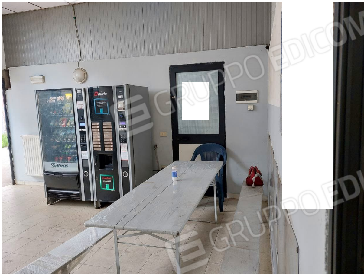
Foto n° 49 – Lotto 1 - Comune di San Vito al Tagliamento (PN) – Foglio 3 mappale 1478 – Zona Industriale Ponterosso – Via Pescopagano n°3. Veduta, dall'ingresso, del locale uso mensa; a sinistra si nota l'uscita verso l'esterno sul lato ovest dell'edificio.
