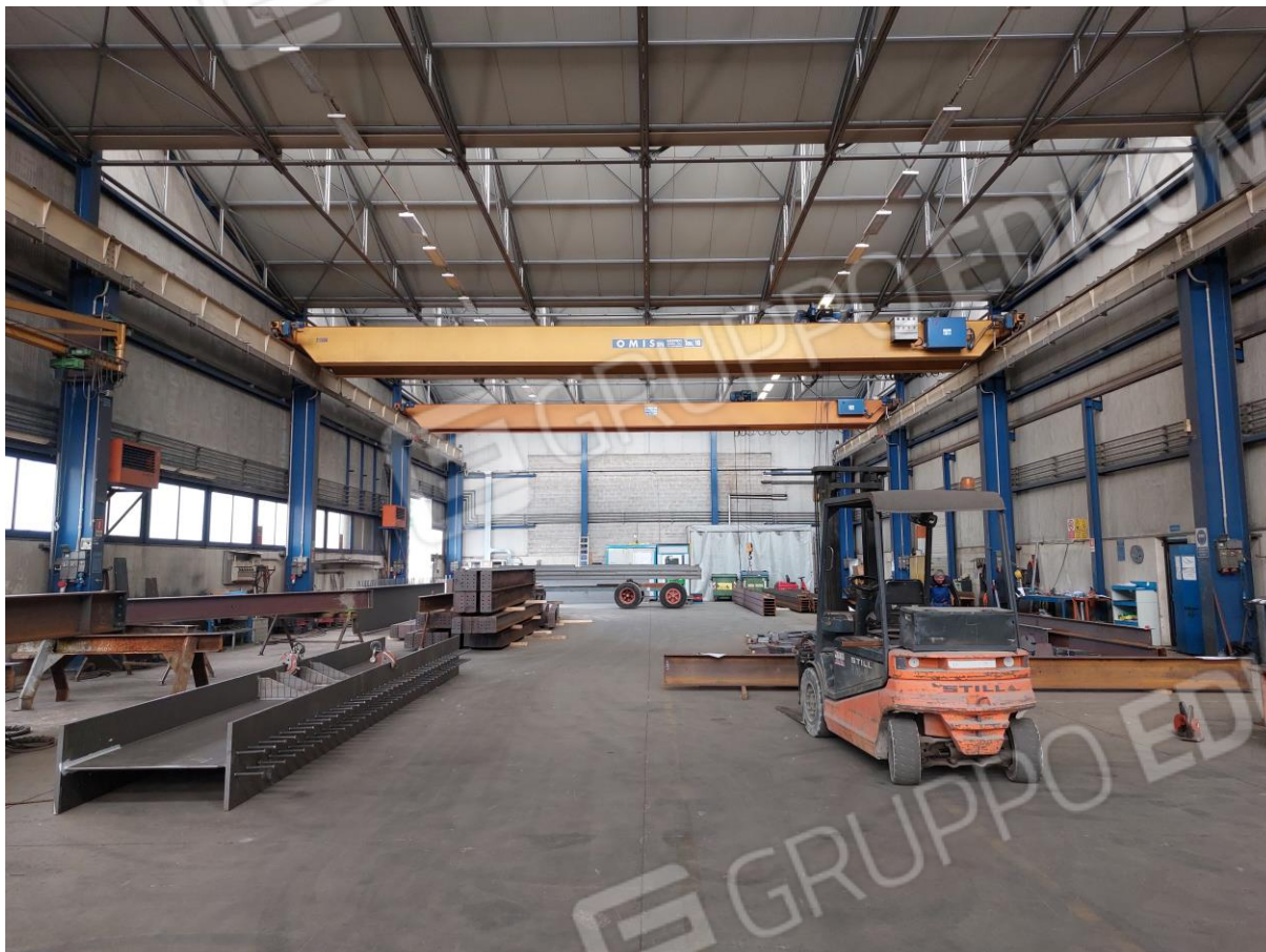
Foto n° 43 – Lotto 1 - Comune di San Vito al Tagliamento (PN) – Foglio 3 mappale 1478 – Zona Industriale Ponterosso – Via Pescopagano n°3. Veduta della zona sud del capannone; sul lato ovest del fabbricato si trovano alcuni locali di servizio (magazzino, ufficio, mensa, servizi igienici e docce, vano compressore).
