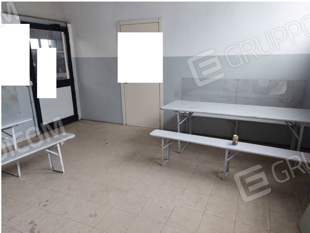
Foto n° 50 – Lotto 1 - Comune di San Vito al Tagliamento (PN) – Foglio 3 mappale 1478 – Zona Industriale Ponterosso – Via Pescopagano n°3. Particolare del locale uso mensa, da posizione opposta alla foto precedente; a sinistra la porta di accesso al capannone dove si svolge l'attività industriale.
