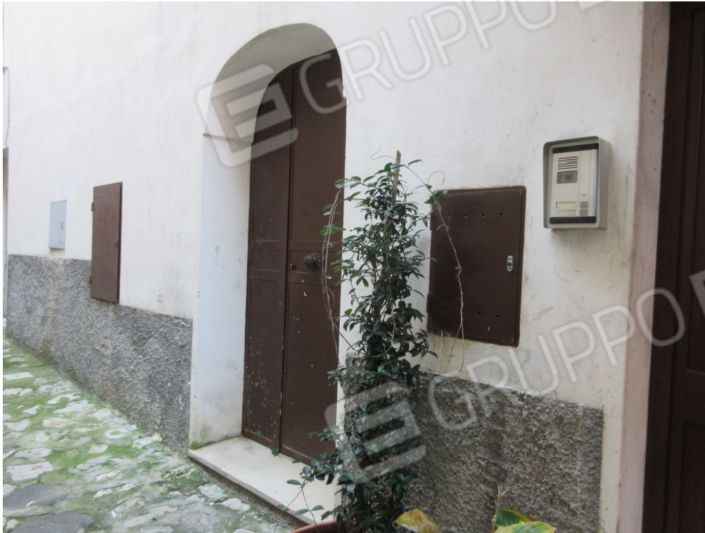
5 Lotto unico: Portone di accesso al locale deposito e magazzino (sub 5).
