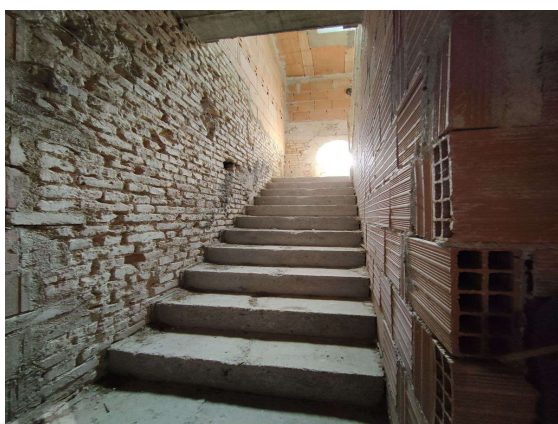
vano scala piano sottotetto
