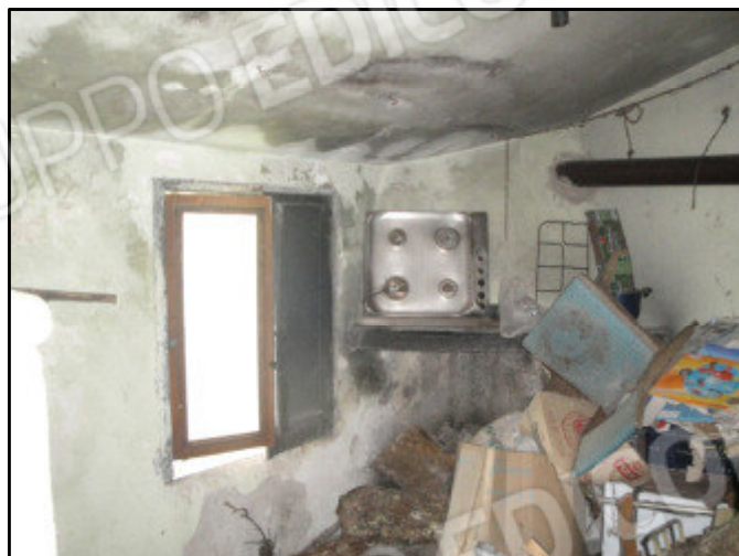
FOTO N. 8 RIPOSTIGLIO - FORNO - LEGNAIA
