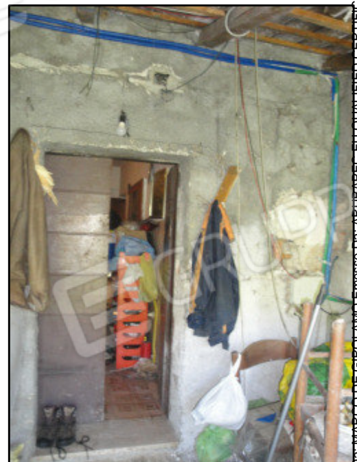
FOTO N. 12 RIPOSTIGLIO INGRESSO RETROSTANTE ZONA "A"
