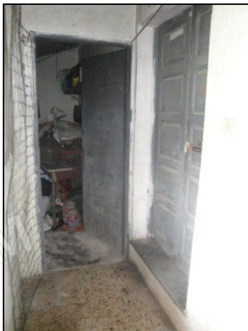
FOTO N. 7 INGRES. RETRO ZONA "B" INGRESSO RIPOSTIGLIO - FORNO
