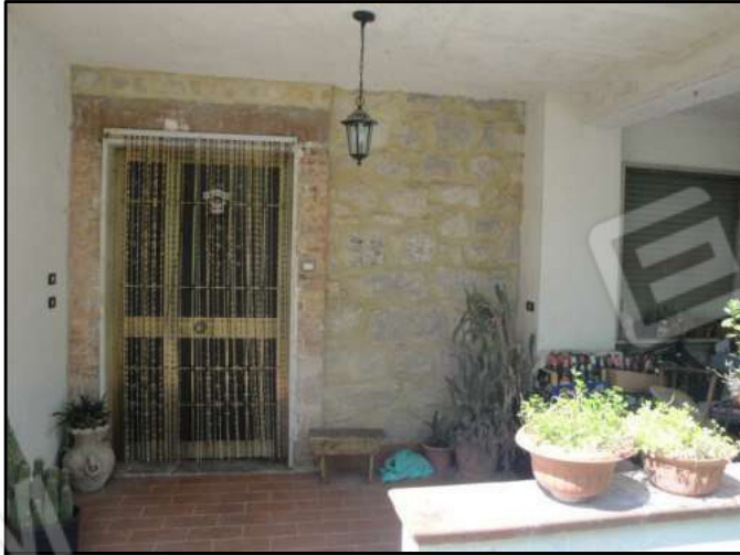
FOTO N. 1 PORTONE INGRESSO ZONA "A"
