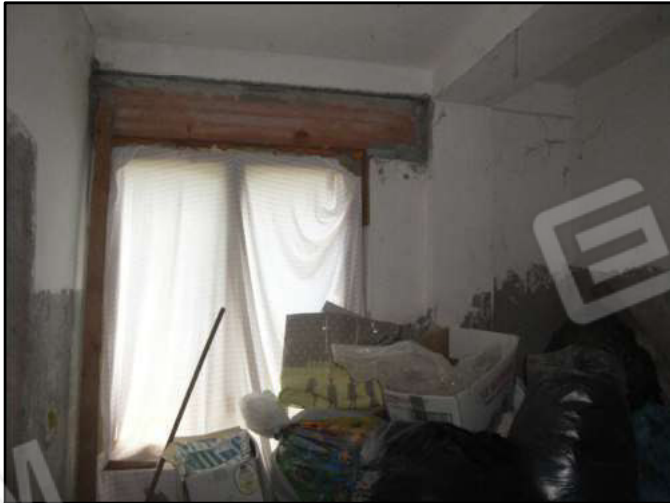
FOTO N. 13 BAGNO IN CAMERA 1 NON REALIZZ.
