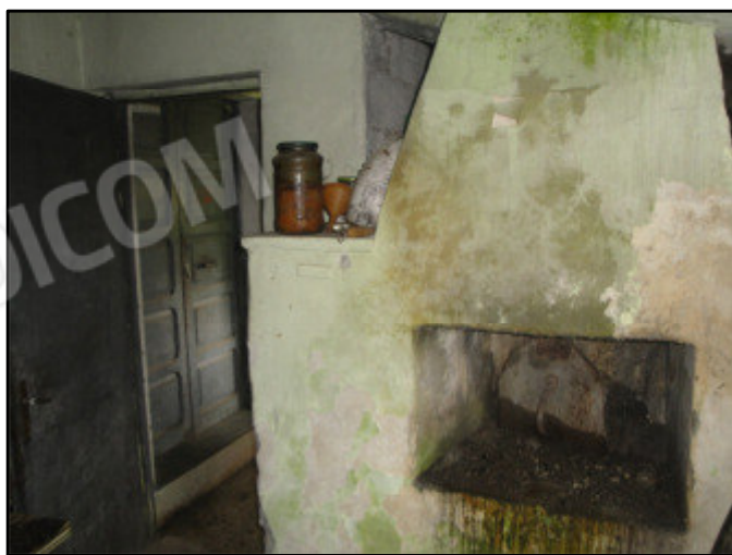
FOTO N. 9 RIPOSTIGLIO - FORNO - LEGNAIA
