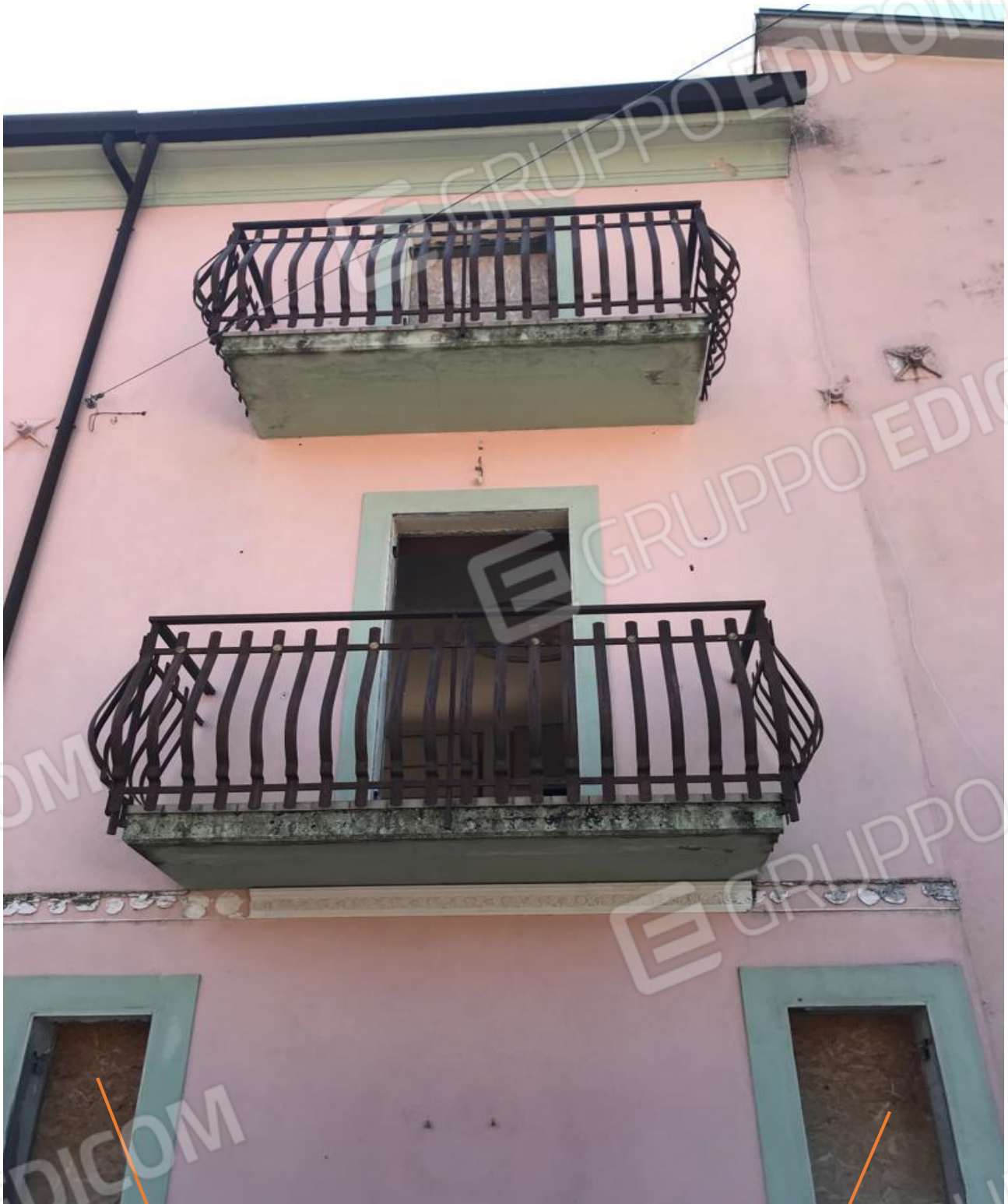
Foto n. 4 – Finestre con pannelli in legno pressato
