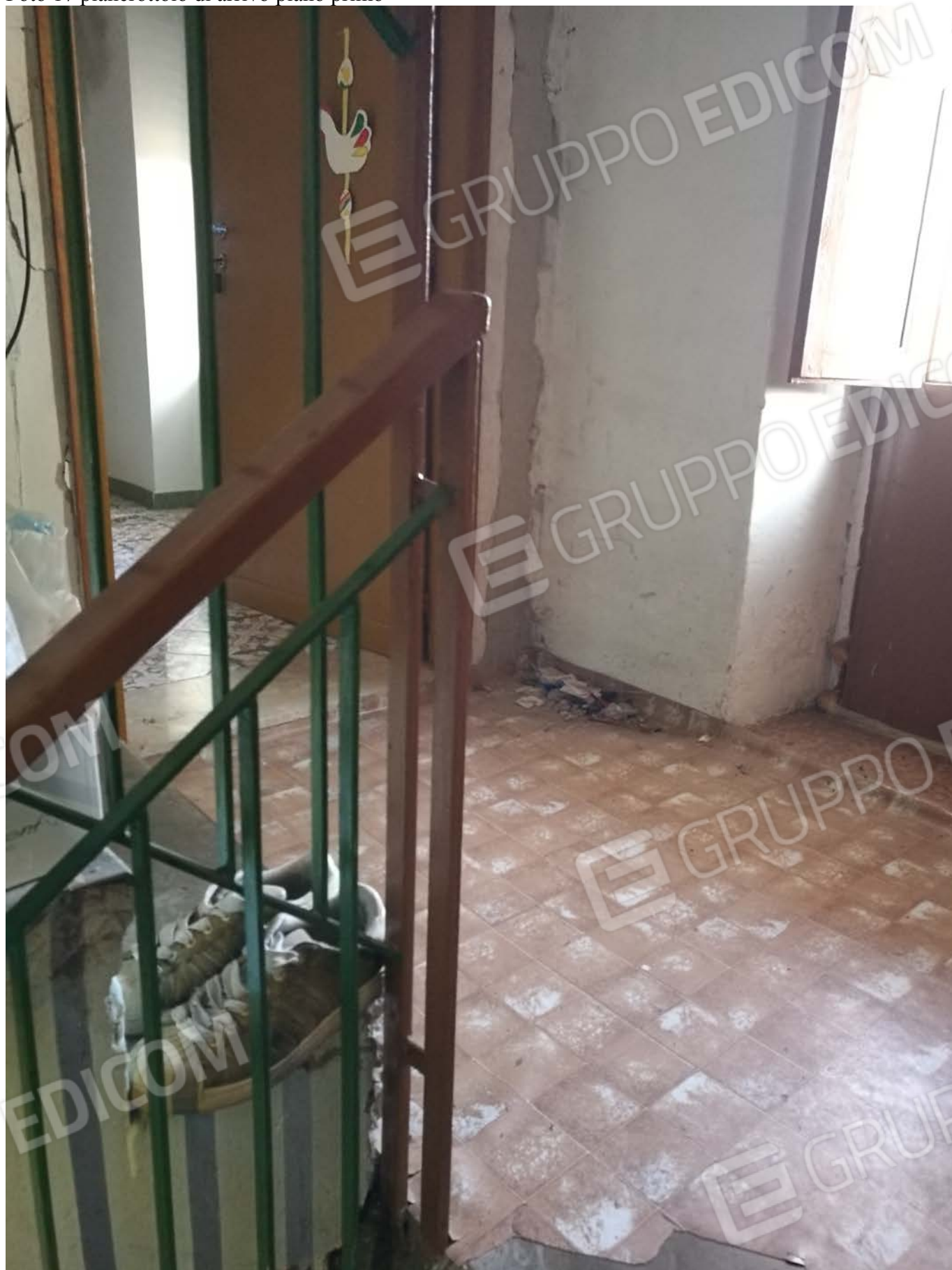
Foto 17 pianerottolo di arrivo piano primo
