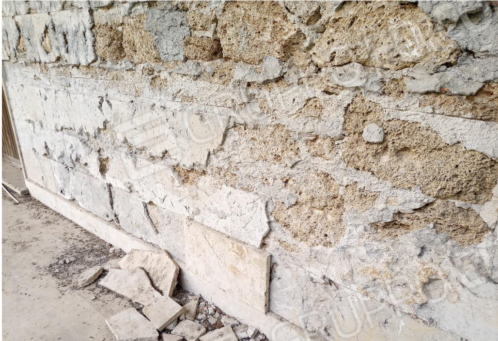
Particolare condizioni muro perimetrale portante
