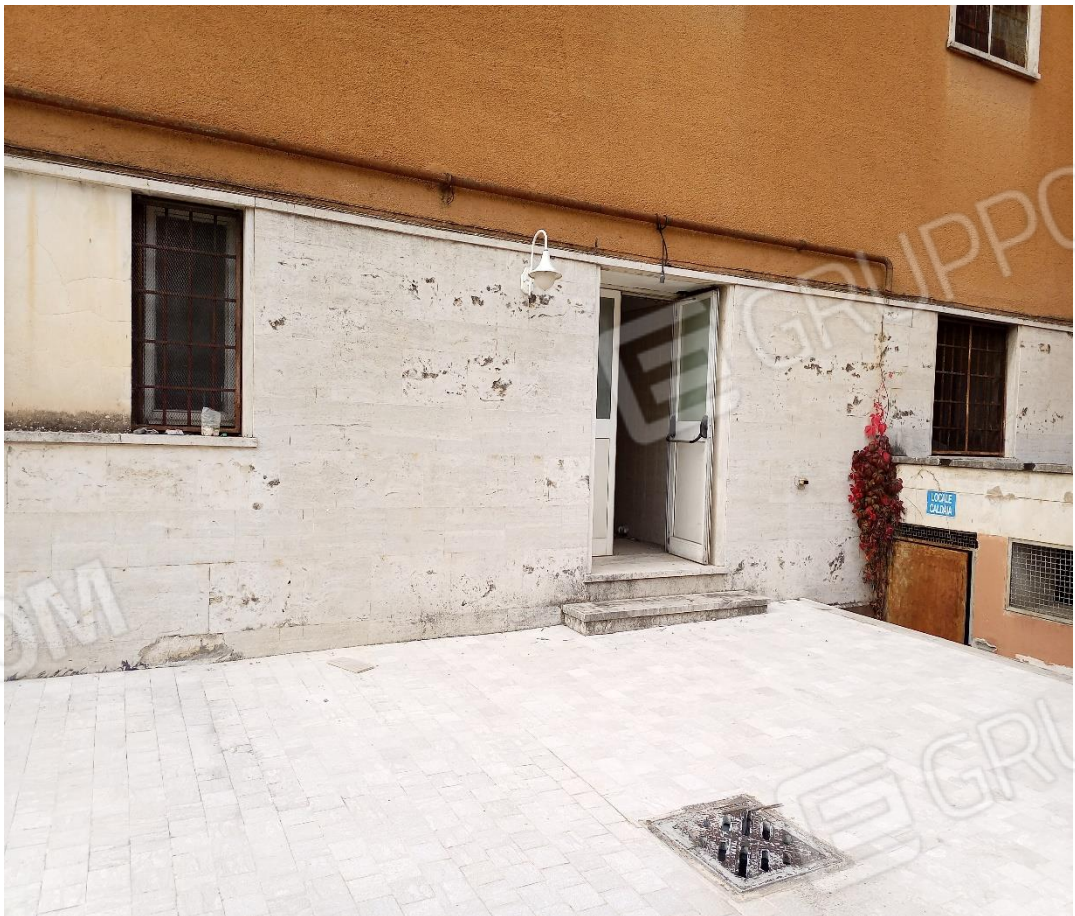
Terrazzino esterno che conduce all'ingresso settore mensa e locali ristorazione
