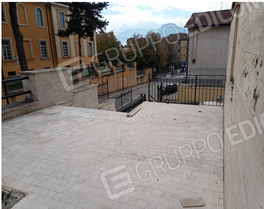
Terrazzino esterno lato sud (La rampa di scala che si intravede a sx, conduce verso altri subalterni che NON interessano la presente Perizia)
