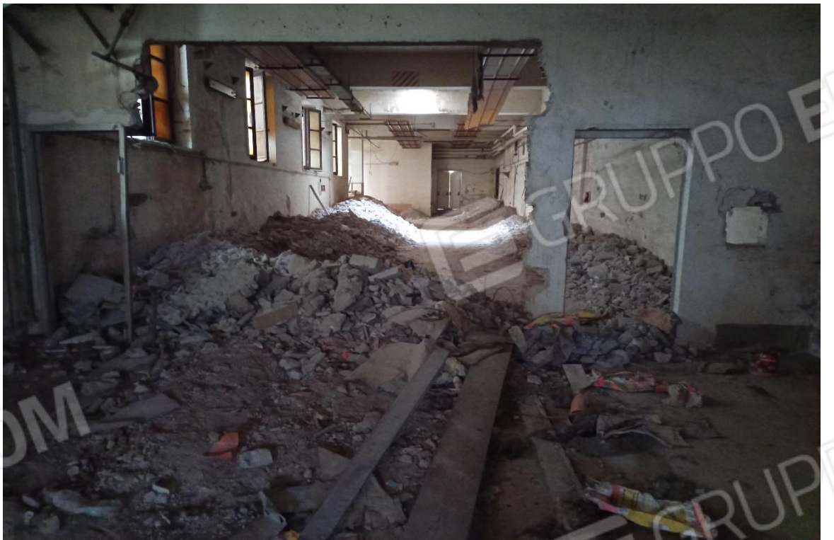
Locale zona lavoro
