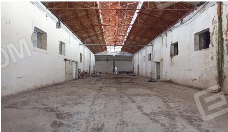
Locale zona lavoro
