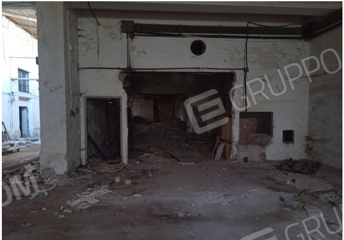
Locale zona lavoro
