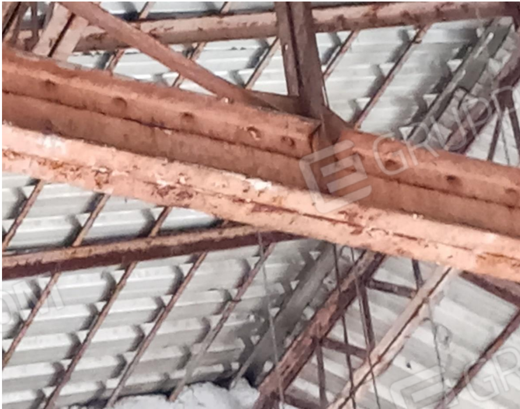
Particolare condizioni d'uso capriata tetto in acciaio
