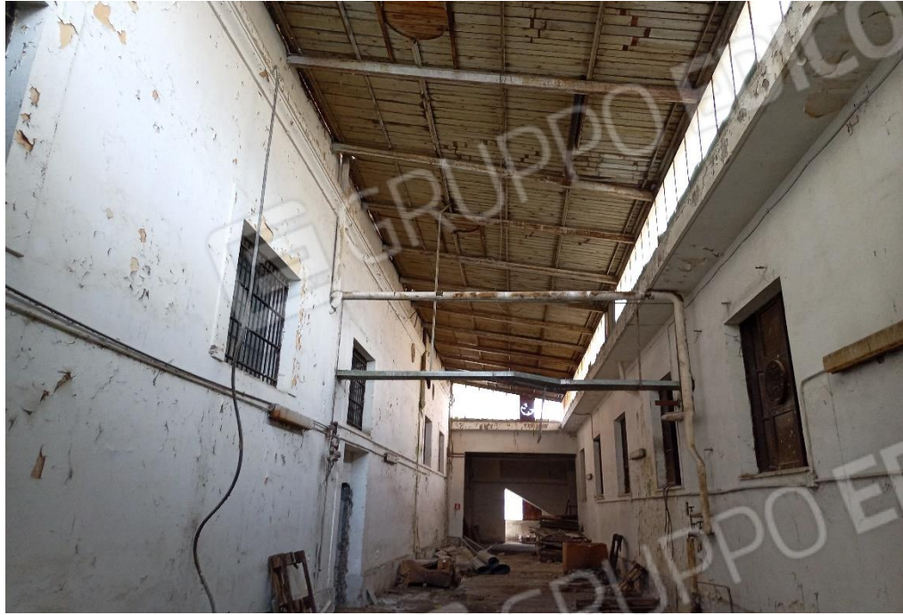
Locale zona lavoro
