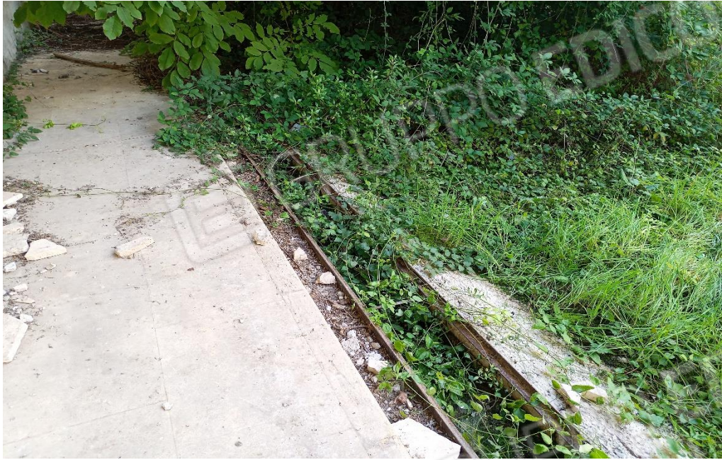
Particolare opera smaltimento acque piovane
