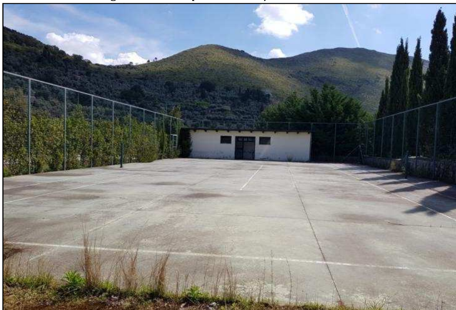
Vista generale campo da tennis/calcetto con servizi
