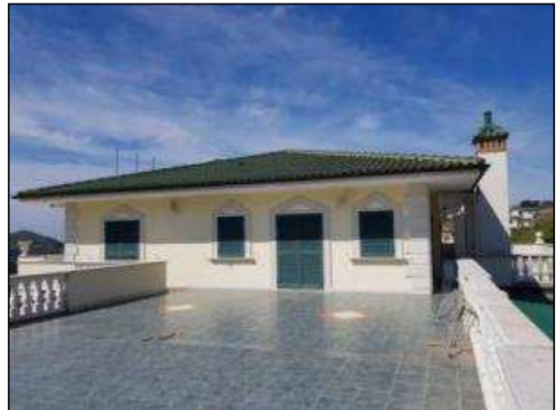
Vista zona terrazzo
