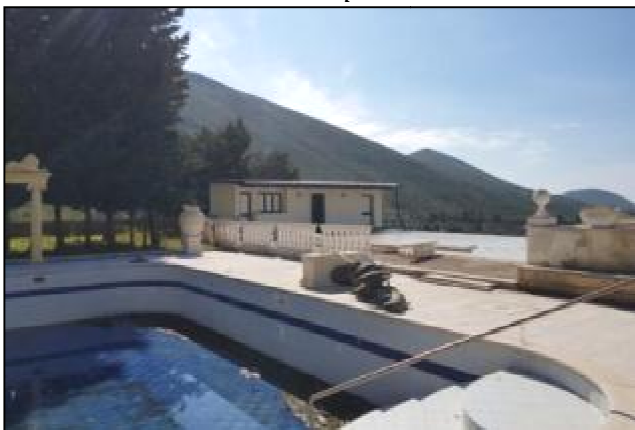
Vista locali di servizio della piscina
