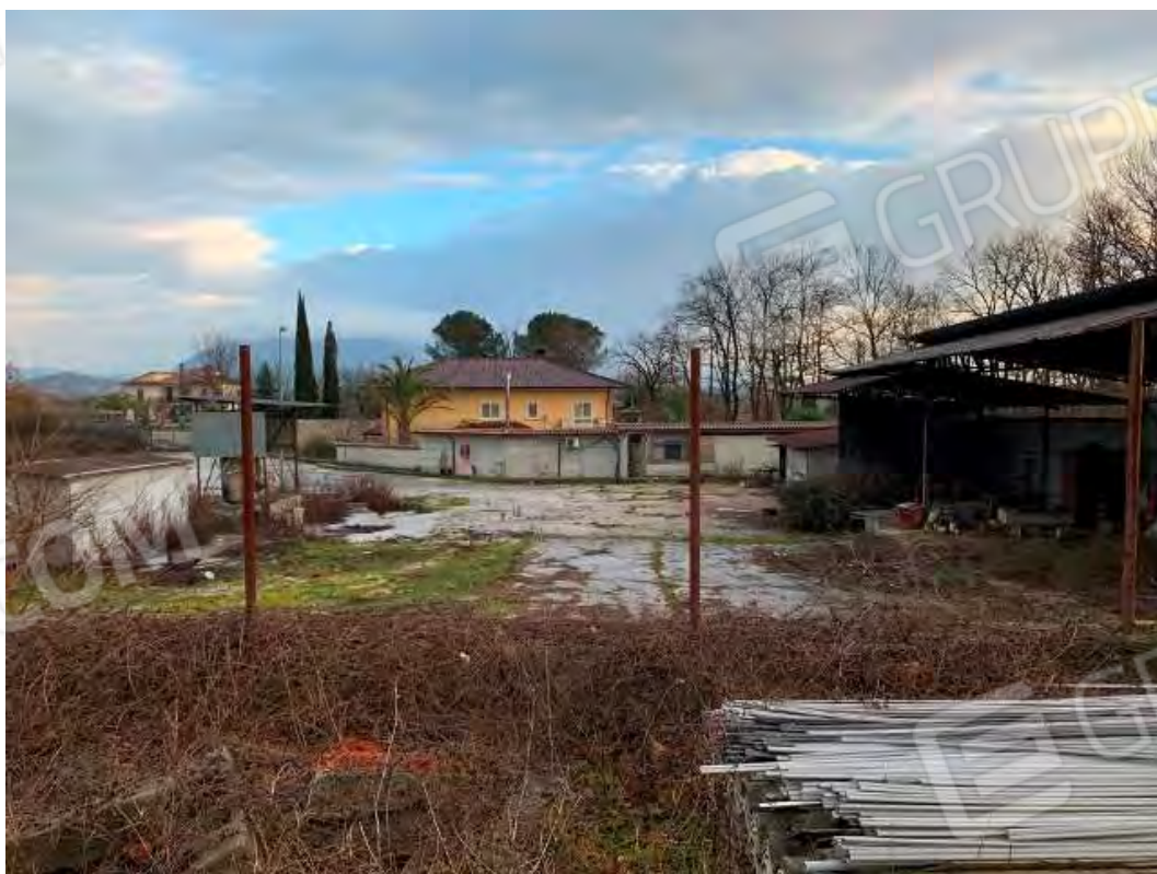
32 Fg67 part 868 863 esterno piazzale
