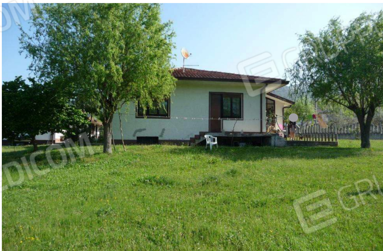
Foto n.4 – Vista esterna bene 1 mapp.754 (fabbricato principale)
