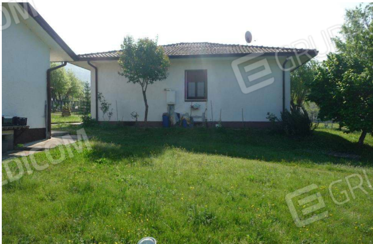
Foto n.6 – Vista esterna bene 1 mapp.754 (fabbricato principale)
