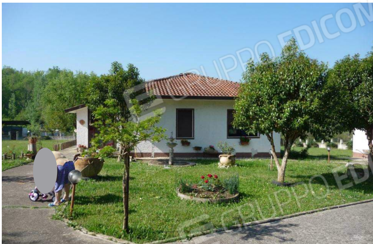
Foto n.3 – Vista esterna bene 1 mapp.754 (fabbricato principale)
