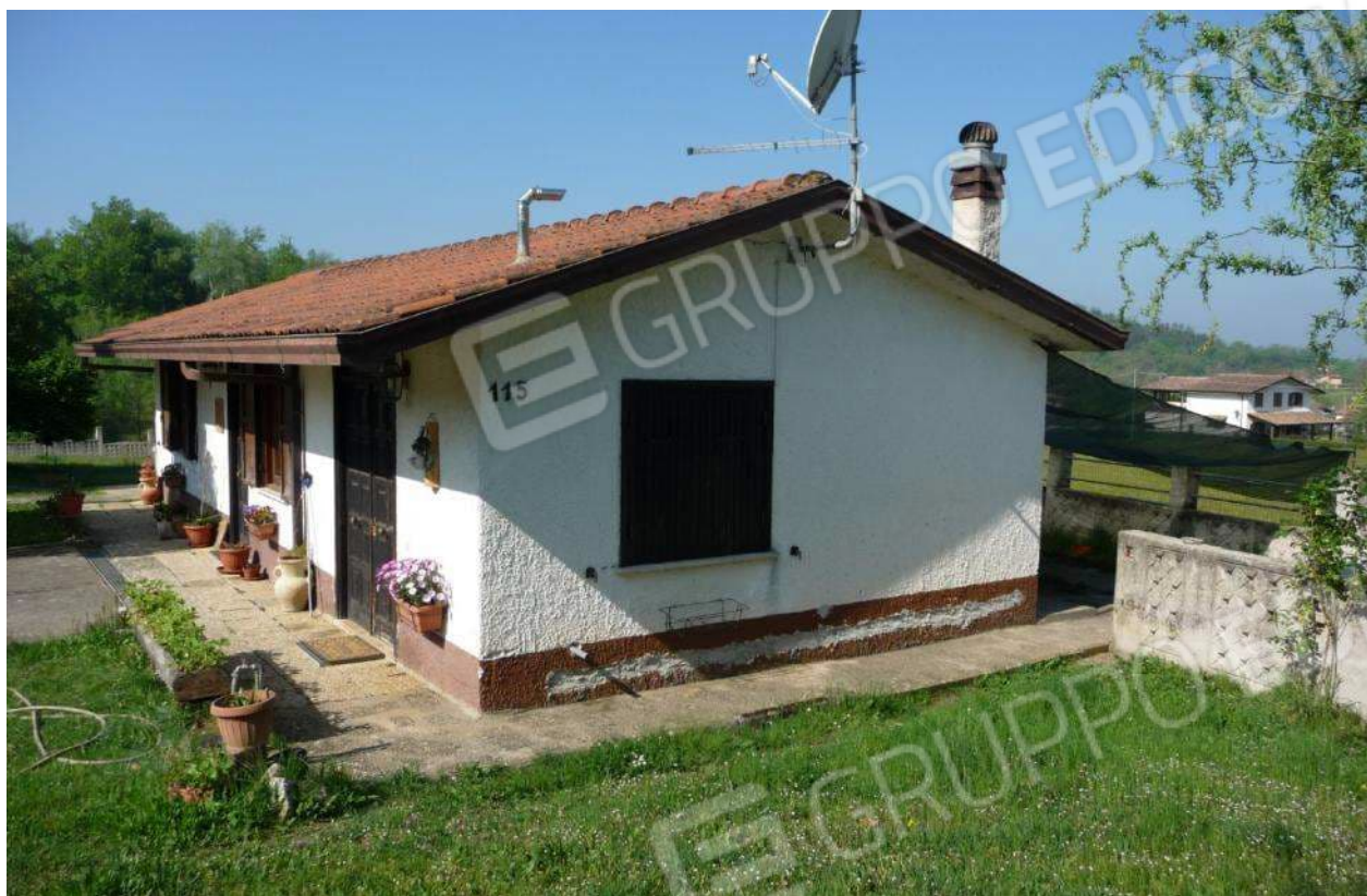
Foto n.7 – Vista esterna bene 1 mapp.754 (fabbricato secondario)
