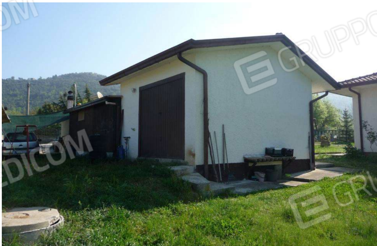
Foto n.8 – Vista esterna bene 1 mapp.754 (fabbricato secondario)
