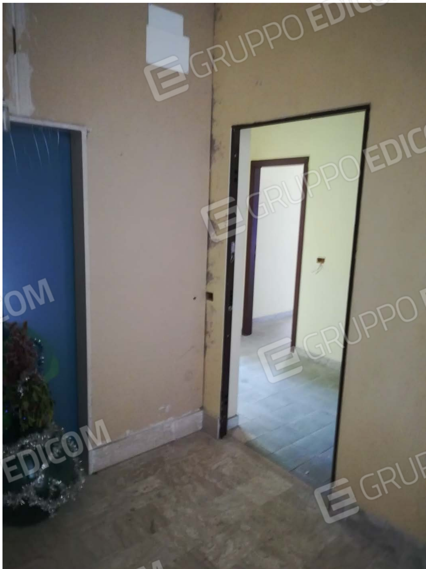
Foto 34 – Scala D piano 2° interno 3
