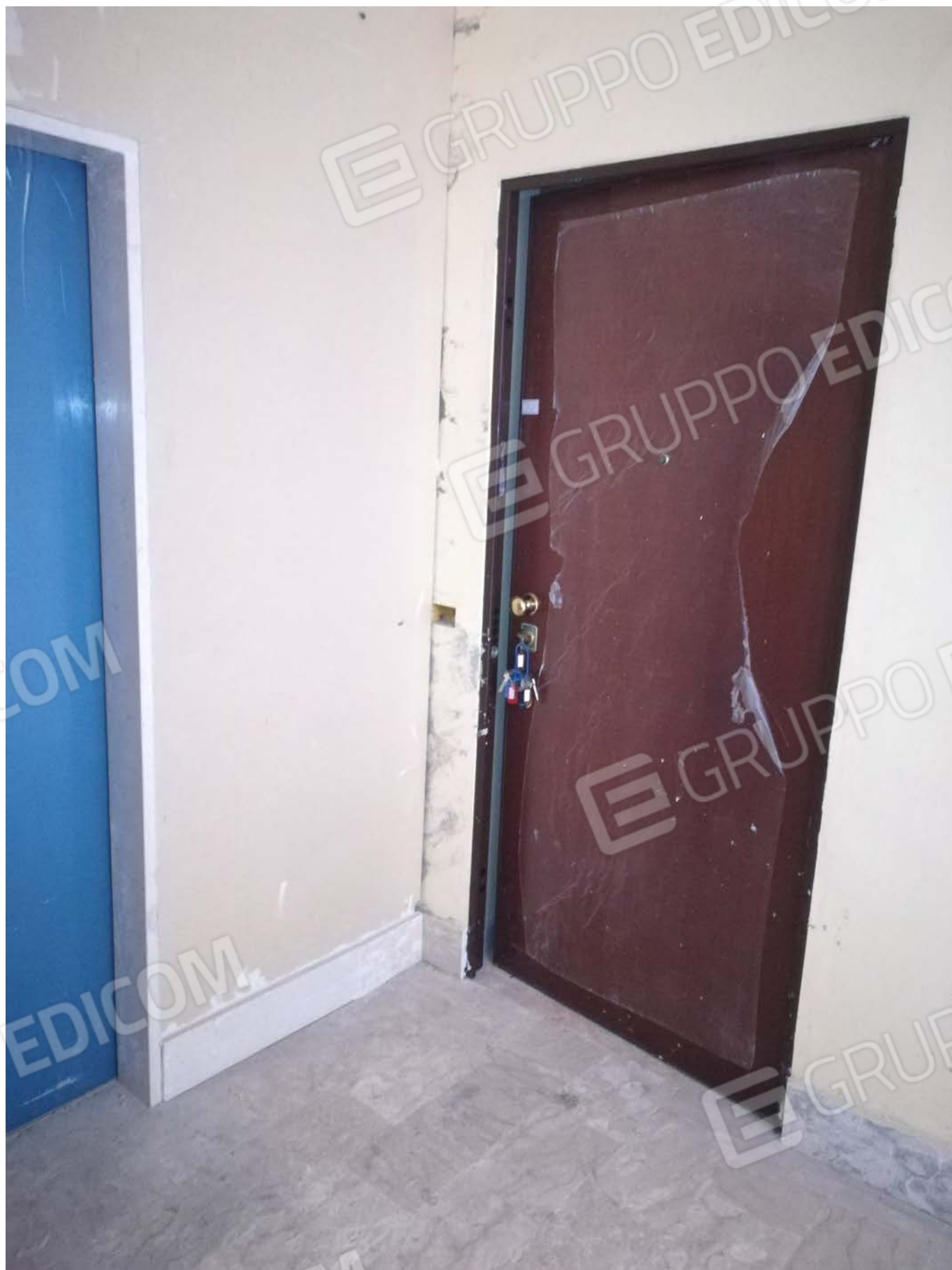
Foto 63 – Scala D piano 4° interno 7
