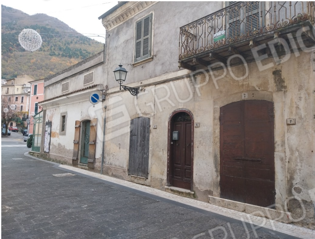
FOTO 3 – Prospetto Ovest –vista laterale del locale commerciale Sub 9 ex sub 5 e 6
