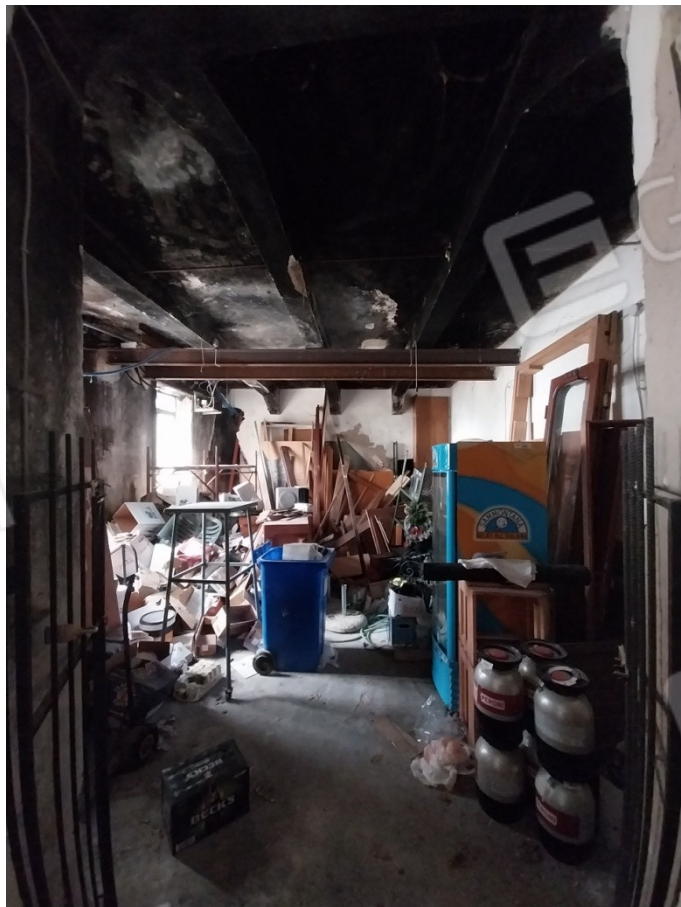
FOTO 6 – locale deposito Sub 8 ex sub 2
