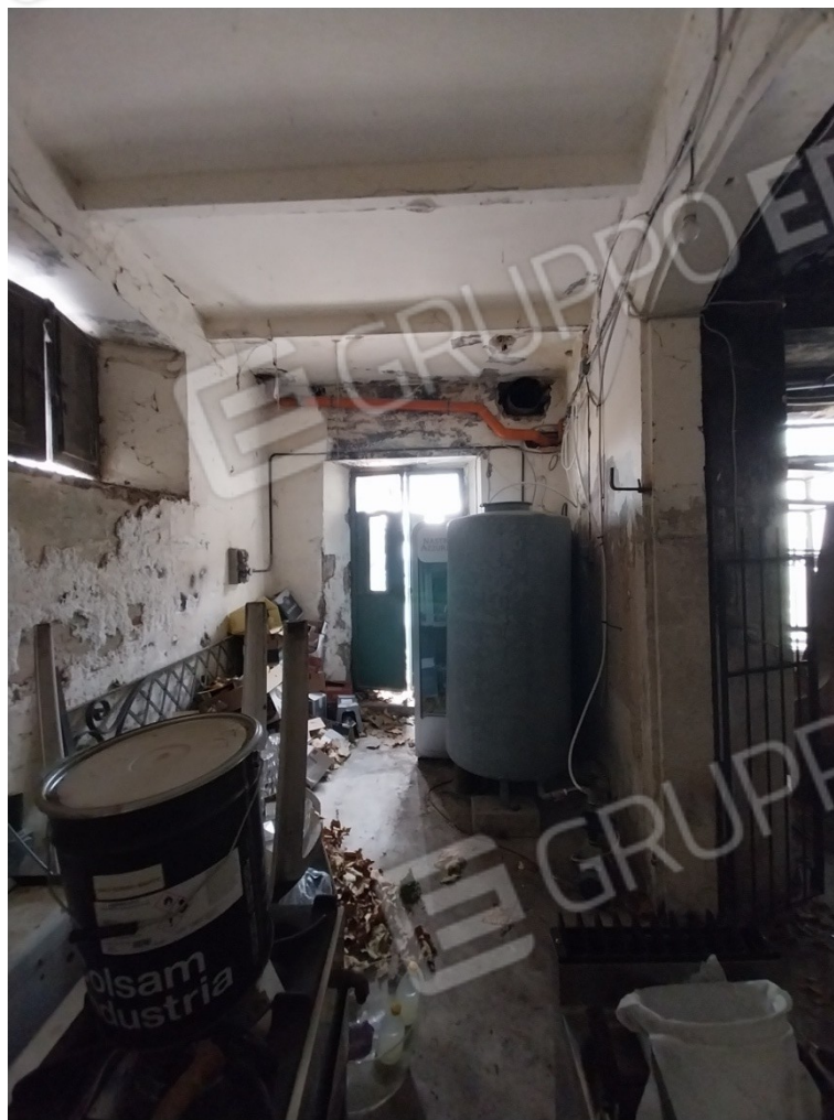
FOTO 3 – locale deposito Sub 8 ex sub 1
