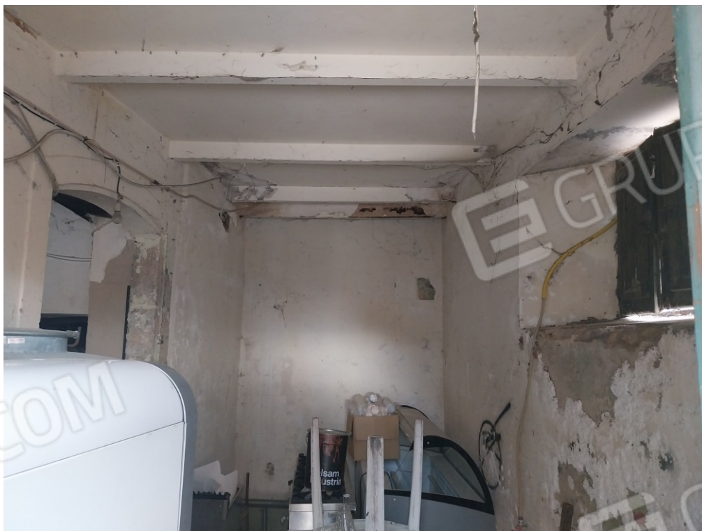
FOTO 2 – locale deposito Sub 8 ex sub 1
