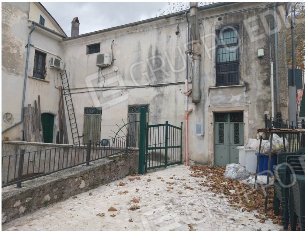
FOTO 1 – Prospetto Sud - Accesso al locale deposito Sub 8 ex sub 1 e 2
