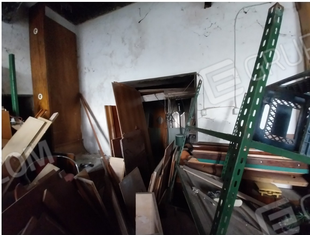
FOTO 8 – locale deposito Sub 8 ex sub 2
