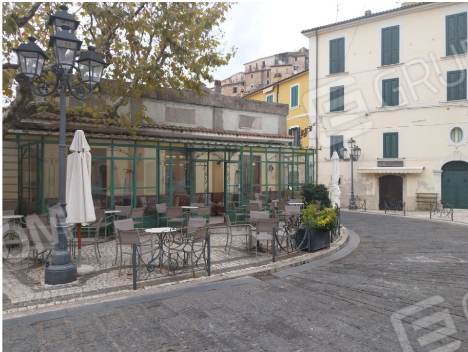
FOTO 2 – vista nord della veranda
