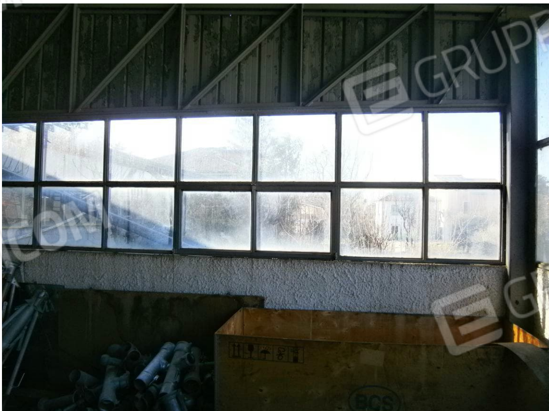
Foto n° 4 - interno capannone "A"
