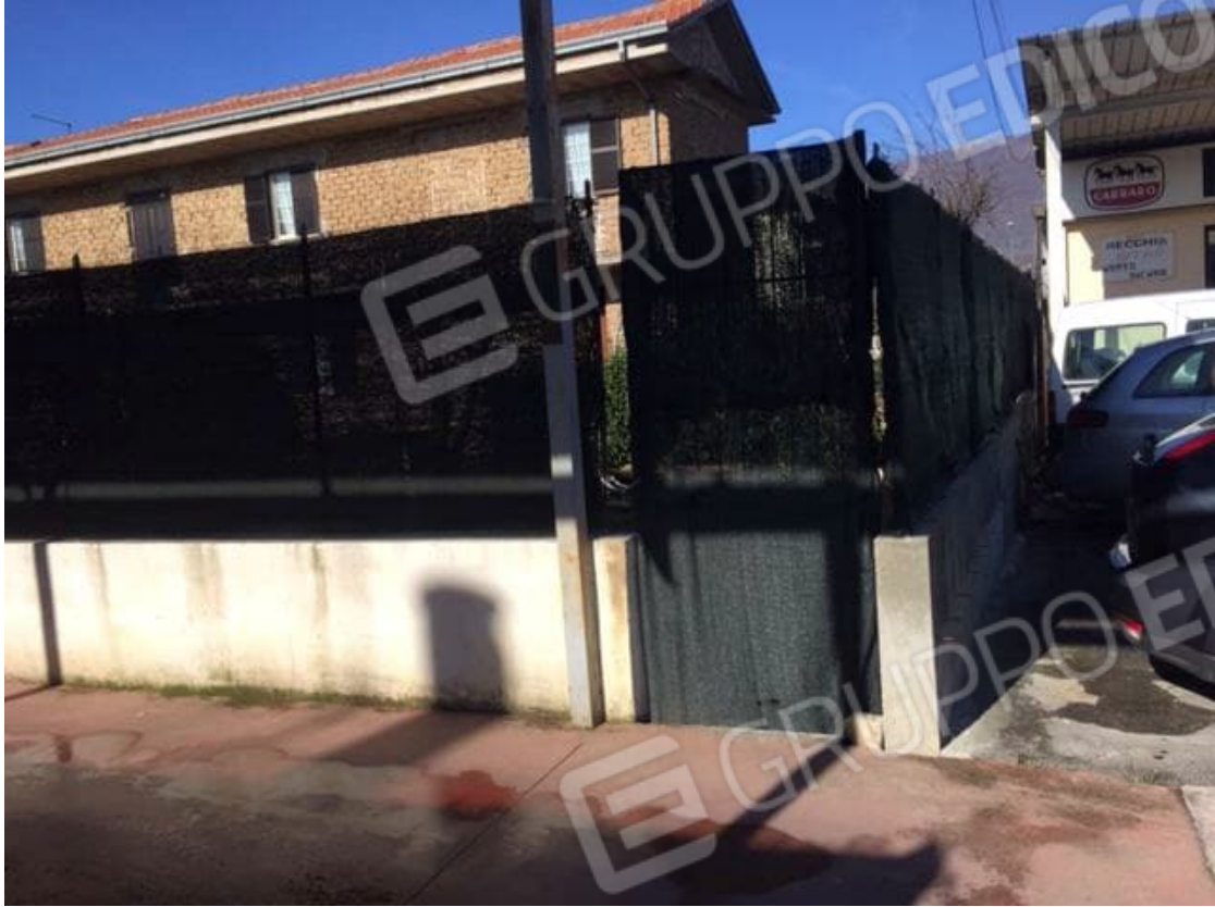
Foto n° 9 - Cannello su Tettoia di passaggio "C"
