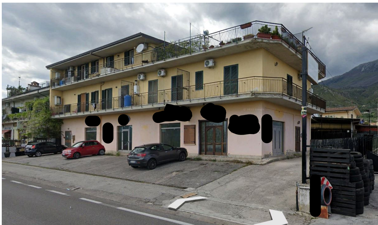
Figura 2: gli immobili si trovano al piano terra dell'edificio in foto
