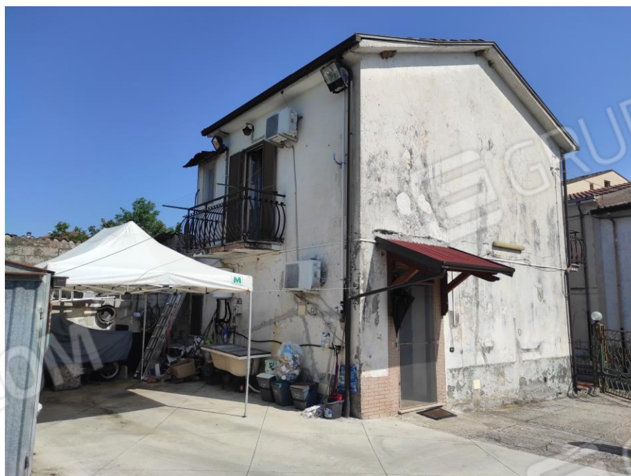
Vista esterna del fabbricato. (Prospettiva lati sud-est e sud-ovest)
