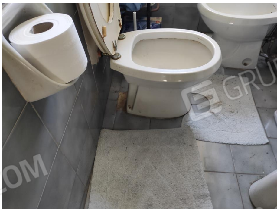
Viste parziali interne del bagno a piano primo in cui si evincono le rifiniture
