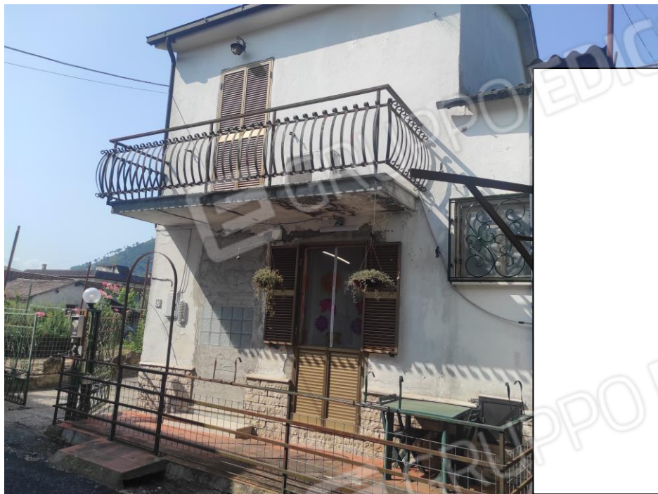
Vista esterna del fabbricato. (Prospetto lato nord-est)
