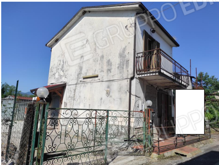
Vista esterna del fabbricato da via Case Vecchie. (Prospettiva lati sud-est e sud-ovest)
