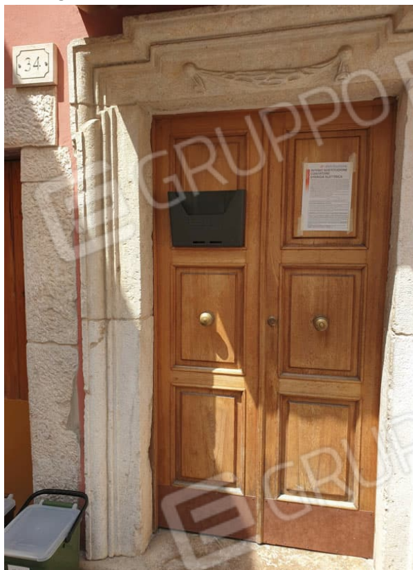
Figura 6: accesso condominiale. Anche se riportato in Catasto il n° civico 77, la targa esposta presenta il n° 34.
