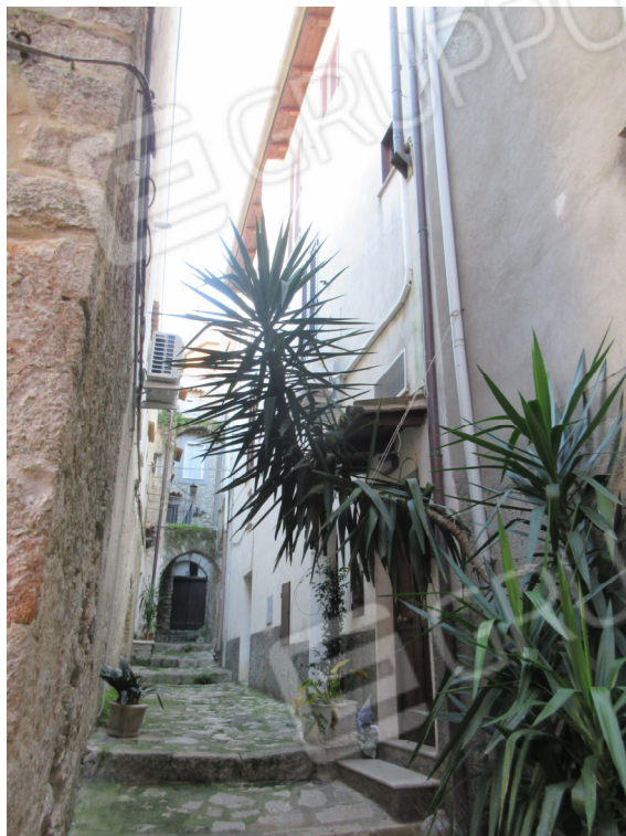
3 Lotto unico: vista del lato Nord dei beni oggetto di esecuzioni attestante su via Vico Casale.
