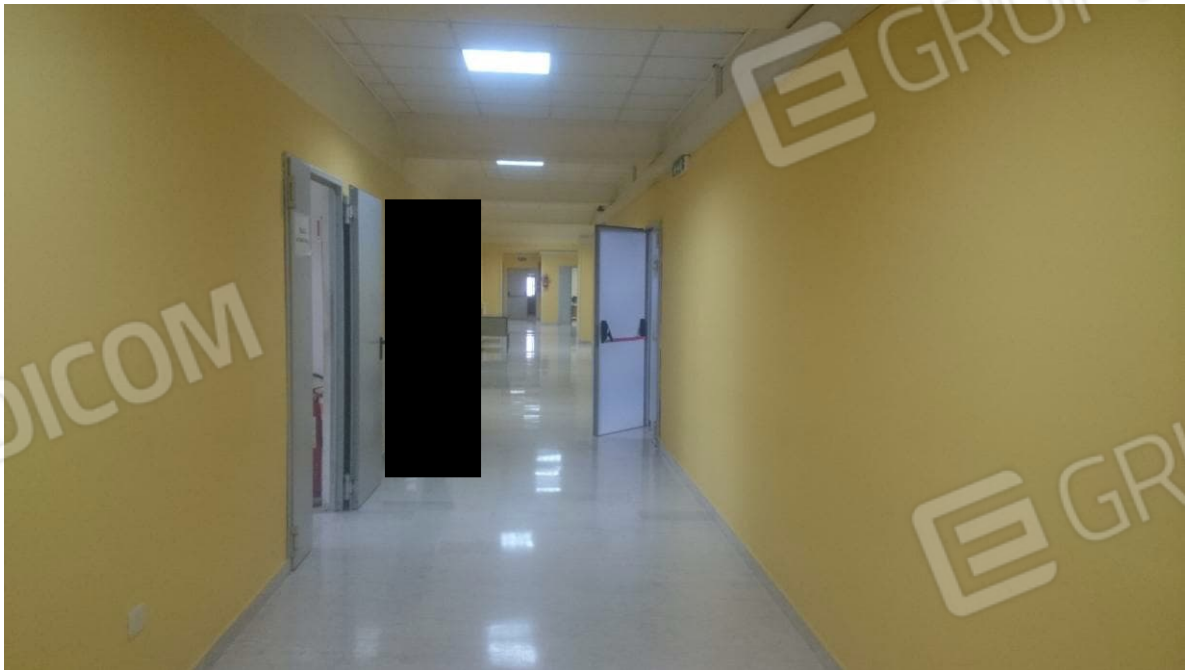
Figura 4 - Corridoio Piano Primo
