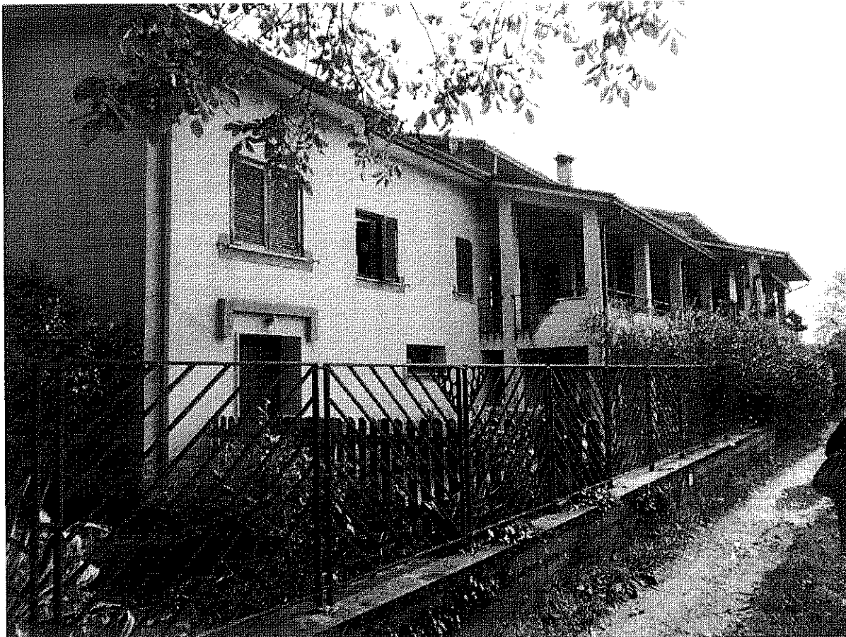
Foto n.7 – Vista del fronte del fabbricato (Lotto n.1)
