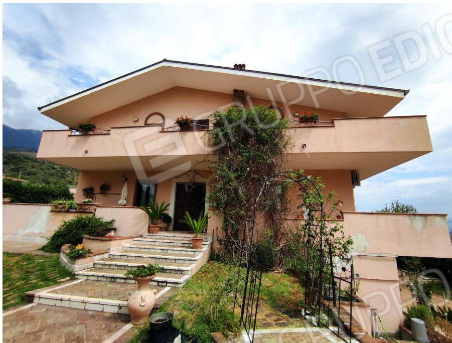
Prospetto frontale lato ingresso del fabbricato in cui sono ubicati i beni oggetto della presente Esecuzione Immobiliare (lato ovest). In cui si evince l'ingresso dei beni n. 1, 3 e 4 contraddistinti con i sub 6,7,8.
