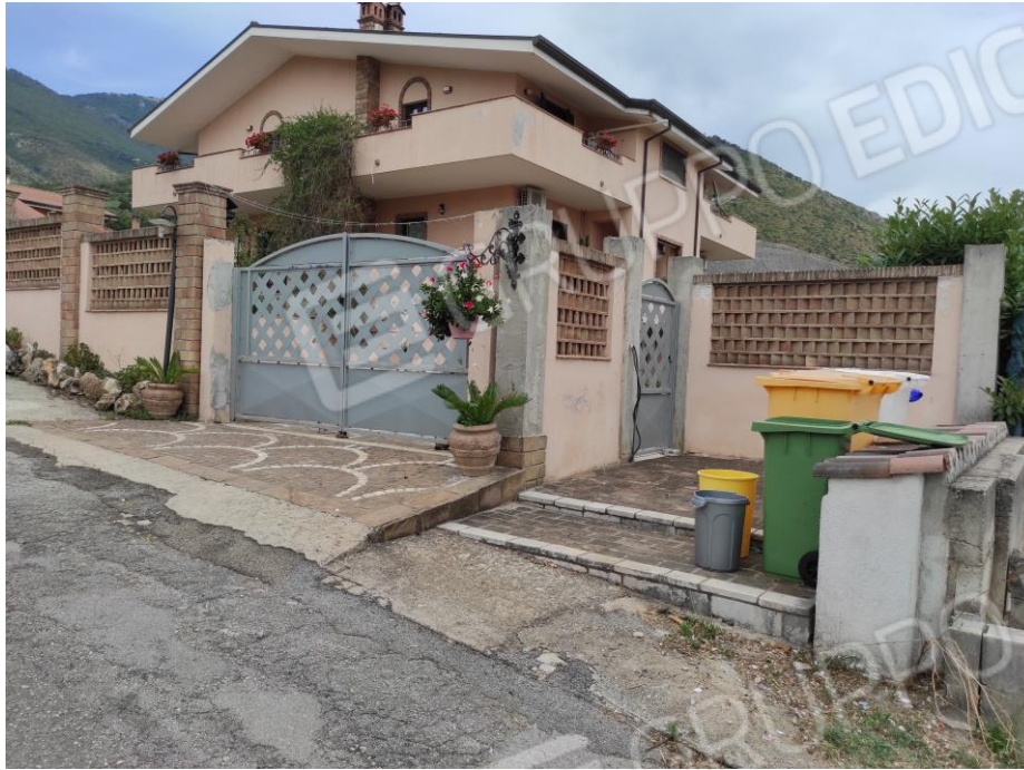
Vista generale del fabbricato da via Grotta Scacciamosca in cui sono ubicati i beni oggetto della presente Esecuzione Immobiliare. (lato sud-ovest)
