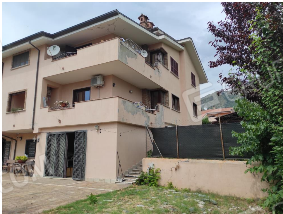
Prospetto laterale del fabbricato in cui sono ubicati i beni oggetto della presente Esecuzione Immobiliare (lato est).
