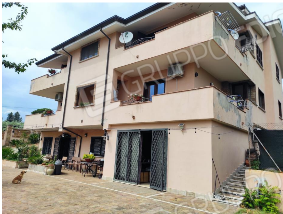
Prospetto laterale del fabbricato in cui sono ubicati i beni oggetto della presente Esecuzione Immobiliare (lato sud). In cui si evince a piano primo sottostrada l'ingresso del bene n. 2 contraddistinto con il sub 5.
