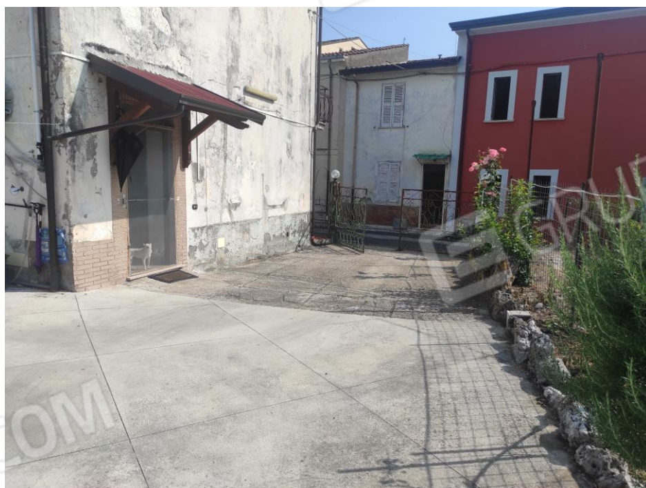
Vista interna della corte
