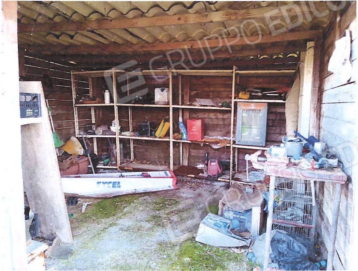
Foto 13 – vista del manufatto all'interno
