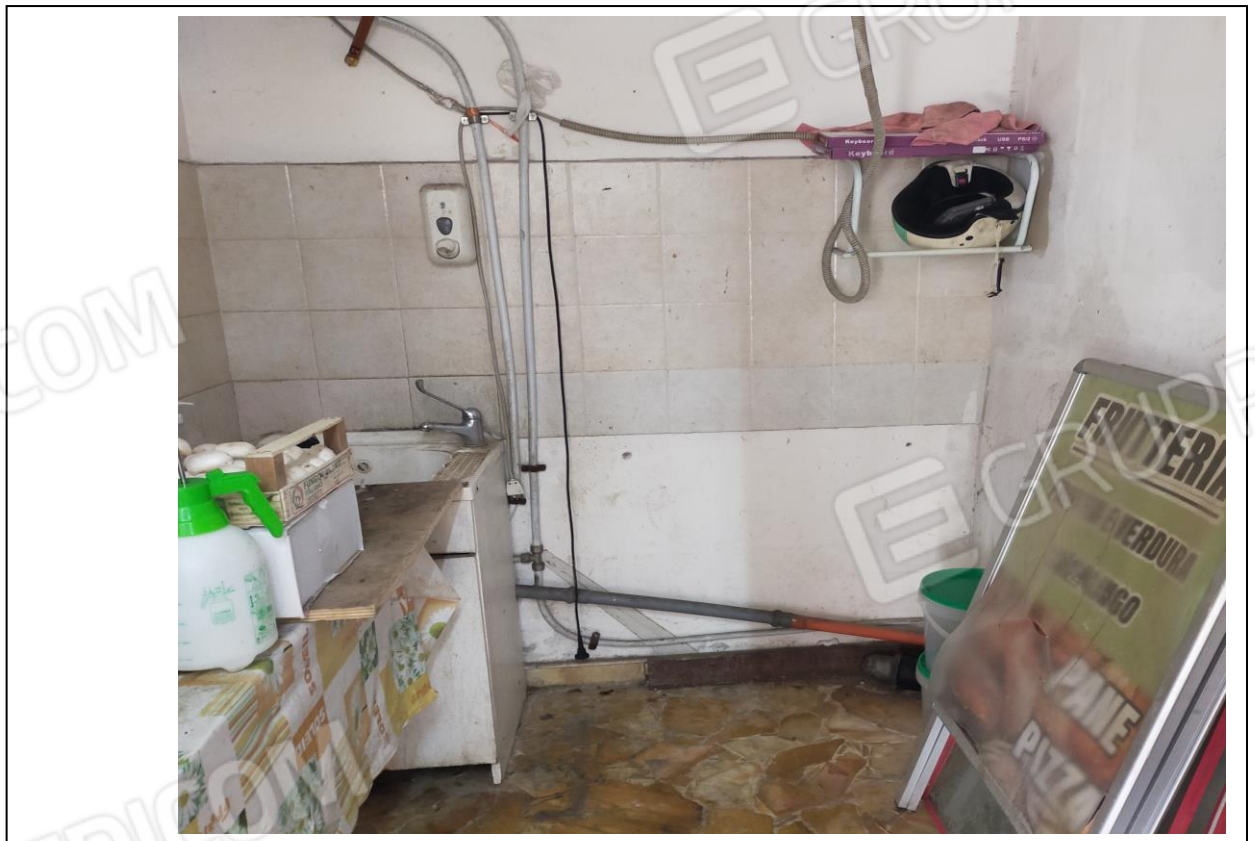
Foto 10 – interno piccolo magazzino
