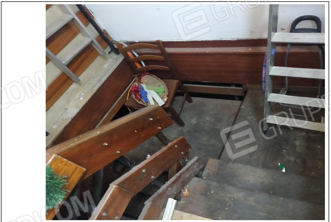
Foto 12 – scala di collegamento con il piano interrato
