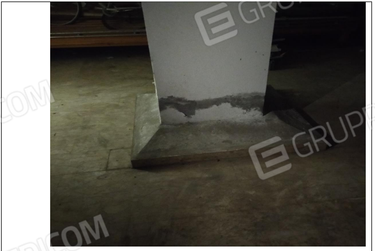
Foto 16 - interno piano interrato
