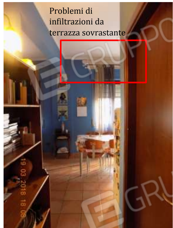
Foto4 Vista Corridoio verso zona Soggiorno/Cucina
