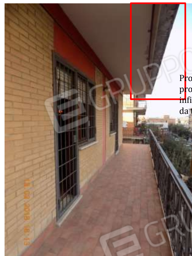
Foto16 Vista Balcone su Viale Italia
