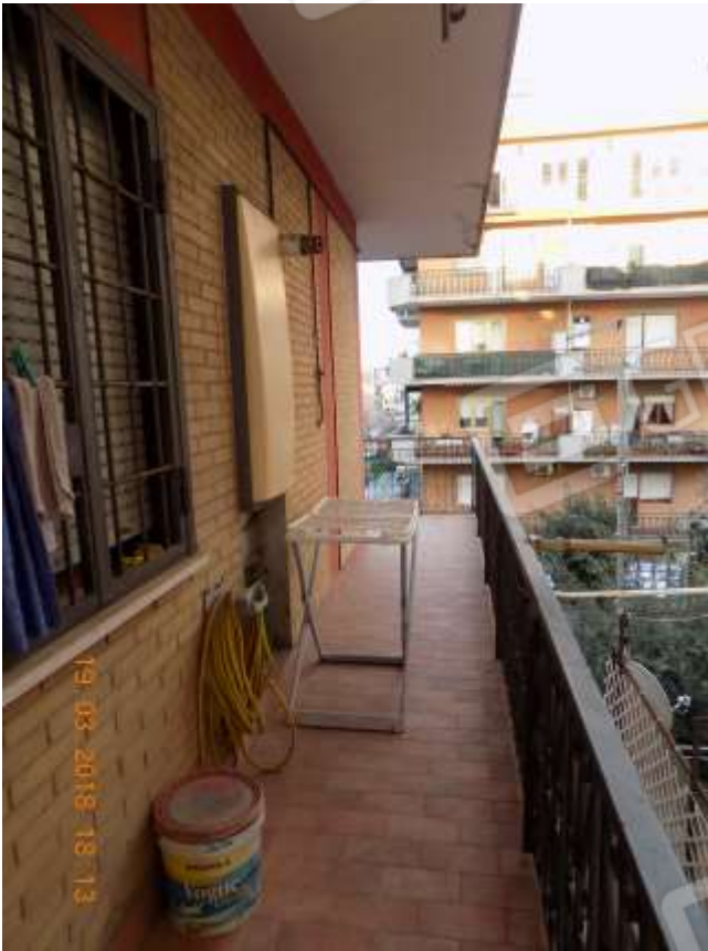
Foto17 Vista balcone Condominio Viale Italia n.95
