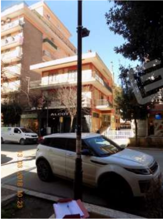
Foto1 Vista della Palazzina su Viale Italia
