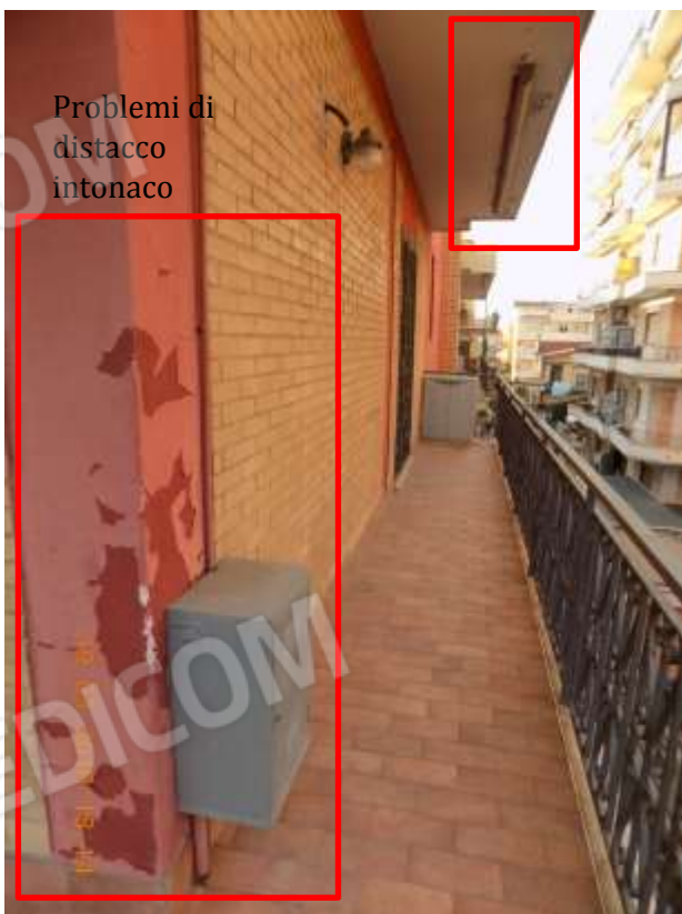
Foto15 Vista balcone verso Cortile Interno
