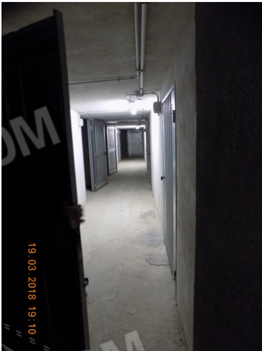
Foto7 Vista Corridoio Est
