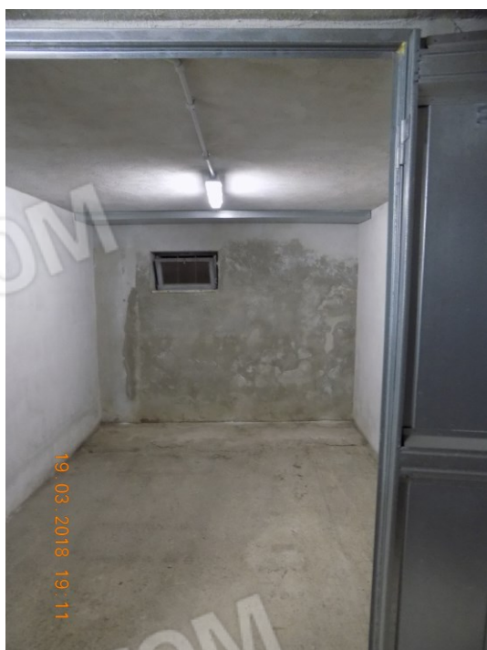
Foto3 Vista interna Cantina tipo con finestra
