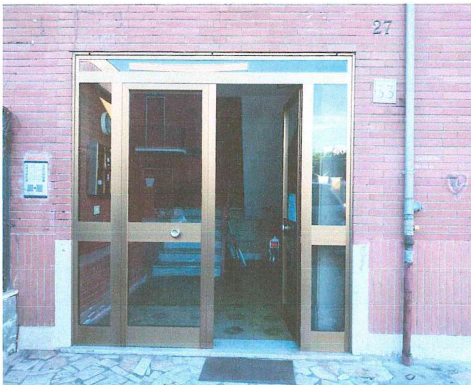
FOTO 4- ingresso alla palazzina condominiale
