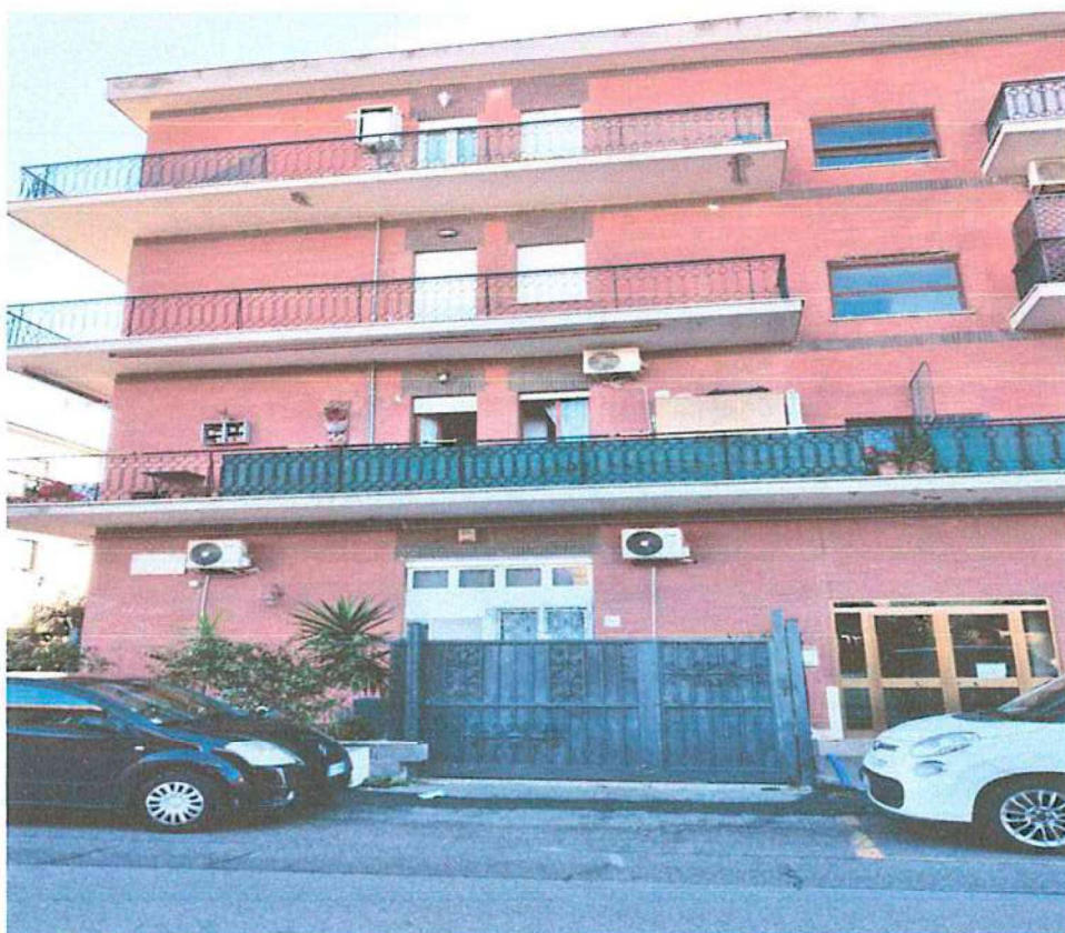
FOTO 3- Palazzina sul fronte via Solinas – al 1° piano l'immobile
