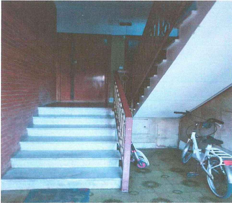
FOTO 5- vano scala condominiale
