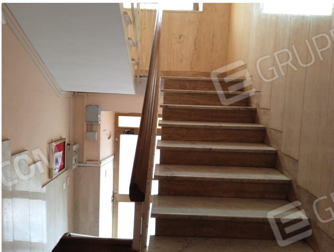
FOTO 4- ingresso al palazzo -vano scala
