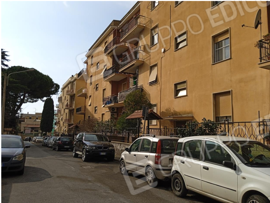
FOTO 1 – via Leopoli – vista verso valle- a destra l’edificio civico n. 46
