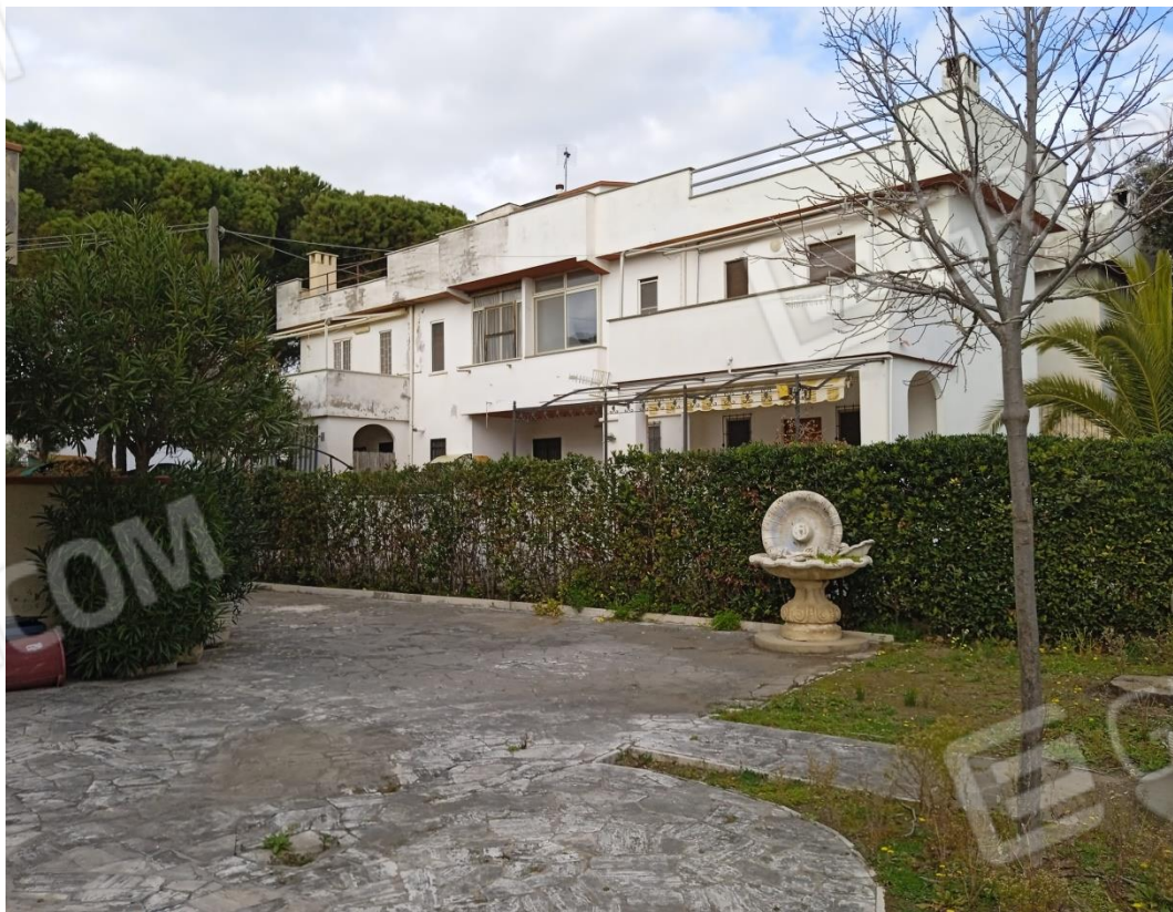
FOTO 8- la corte verso il confine con altra proprietà lungo il vialetto d'accesso
