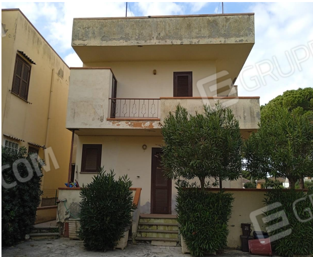
FOTO 10- prospetto frontale sul retro rispetto a via dell'Elba
