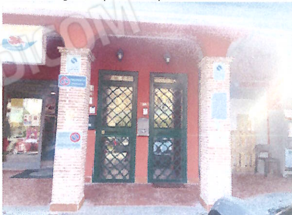
Portoncini di ingresso al piano terra - punto di vista 1H
