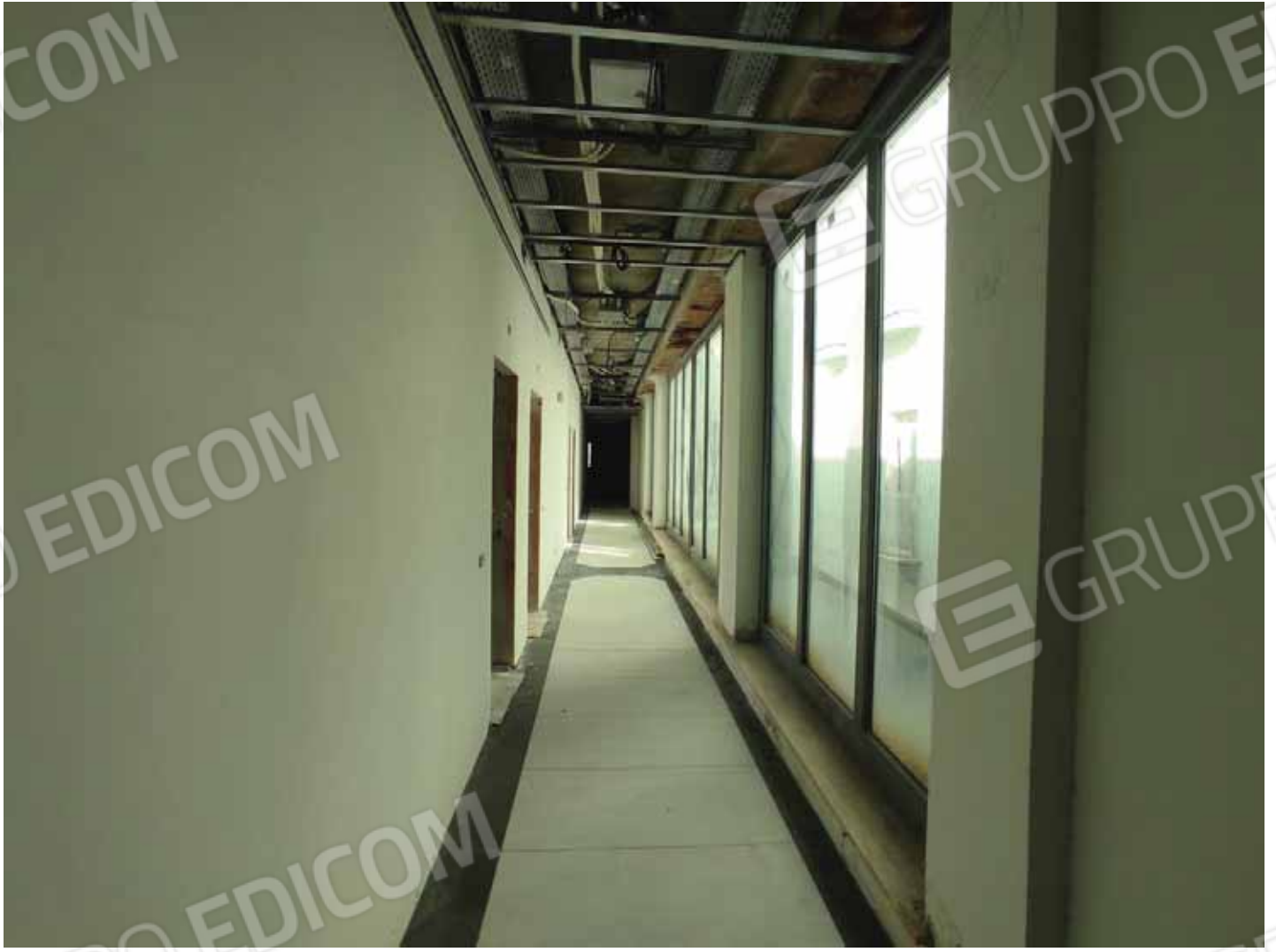
Corridoio piano terra
