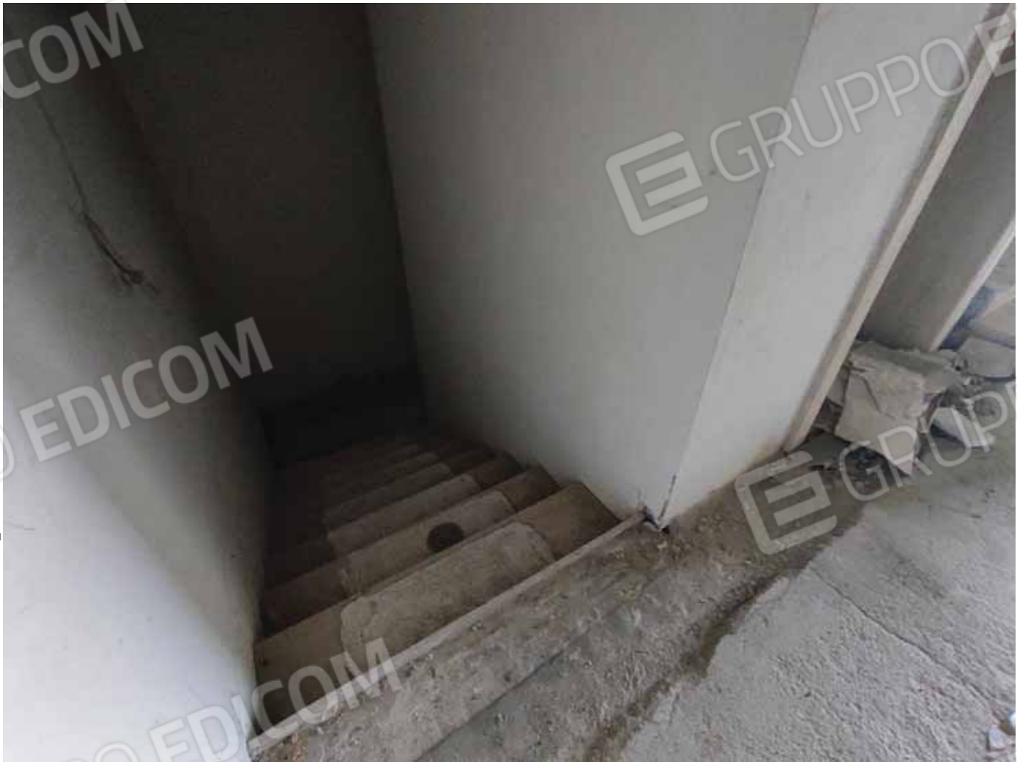
Vano scala verso piano seminterrato
