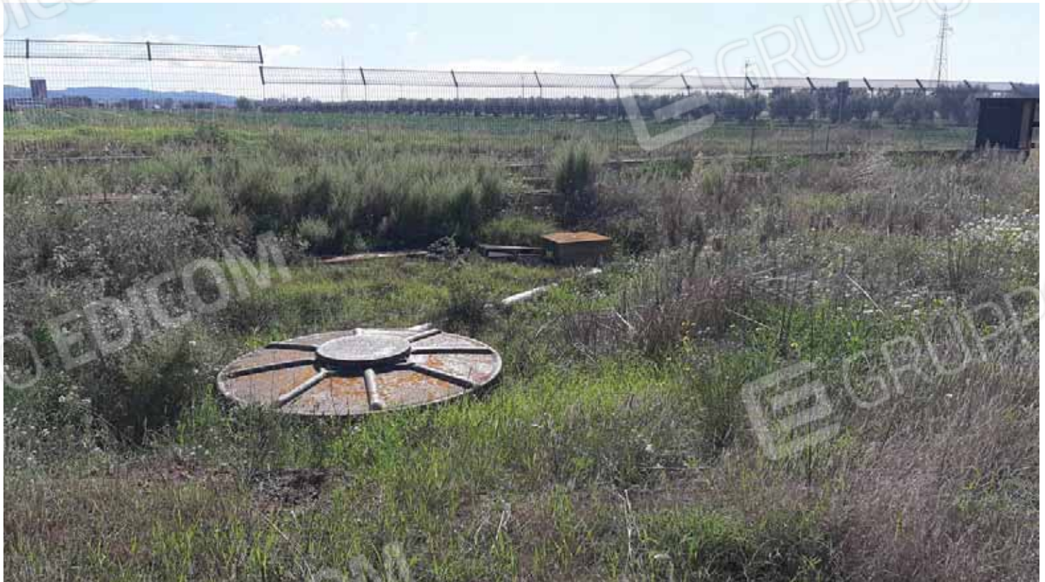
Foto terreno, Foglio 123, part. 45/59/100, impianti tecnologici.
