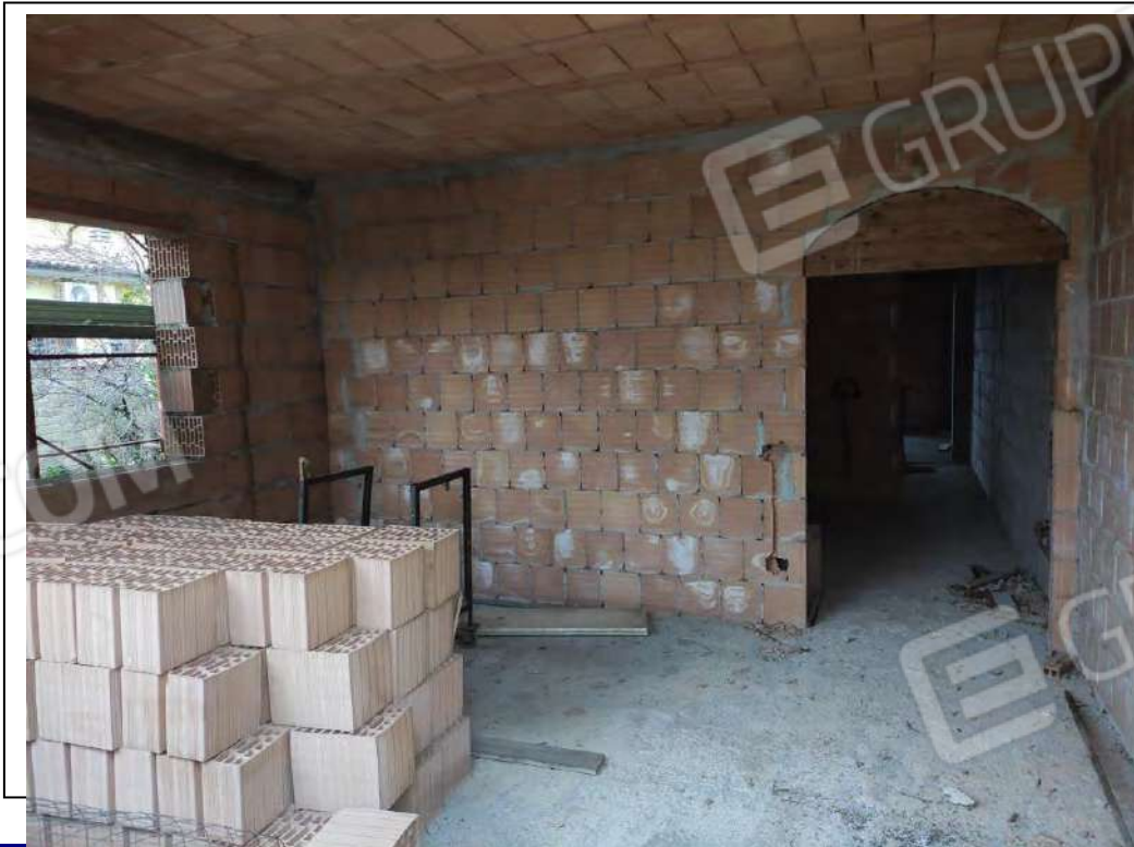
FOTO 10 - Sub. 502 – Piano Terreno
