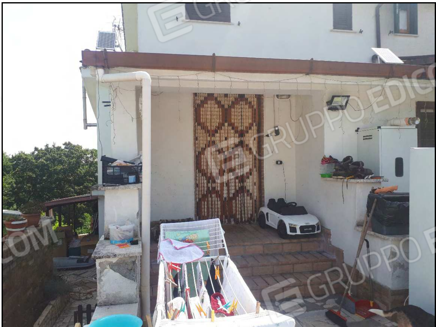
Accesso principale al piano terra
