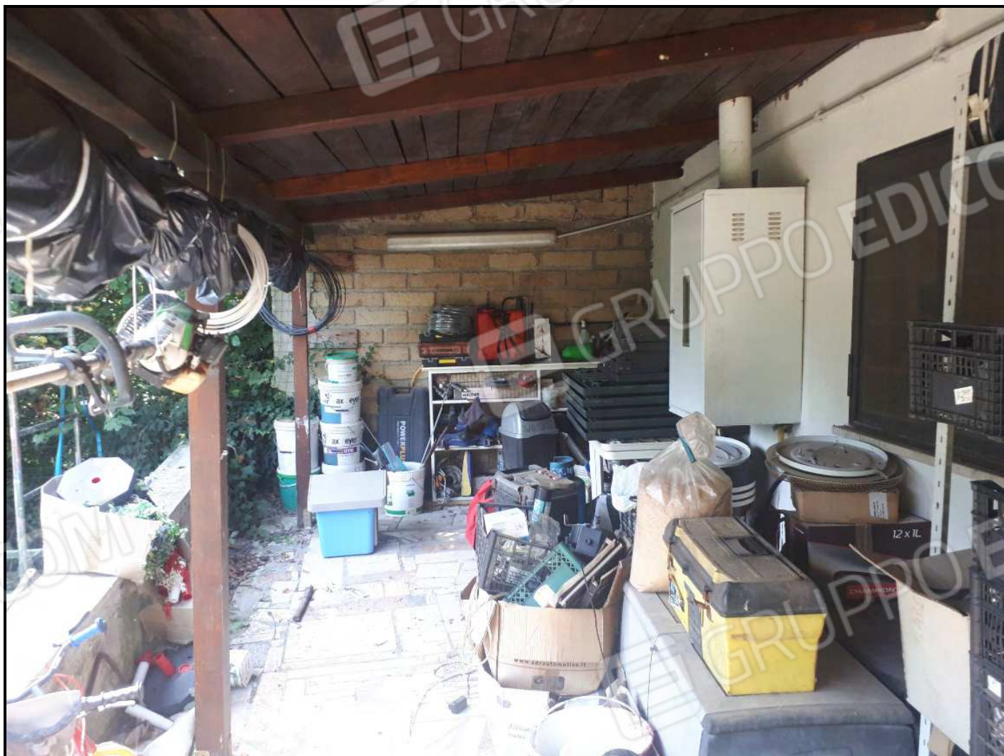
Portico al piano seminterrato
