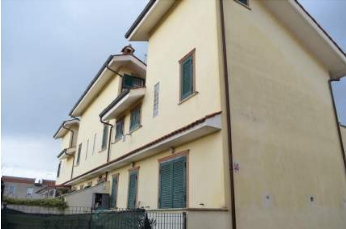
Foto 1: Vista esterna edificio
