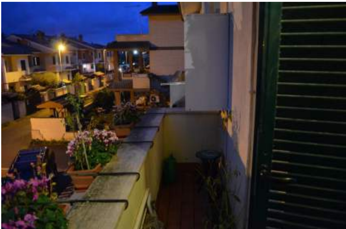
Foto 30 – Lotto 3 Piano Primo: Balcone
