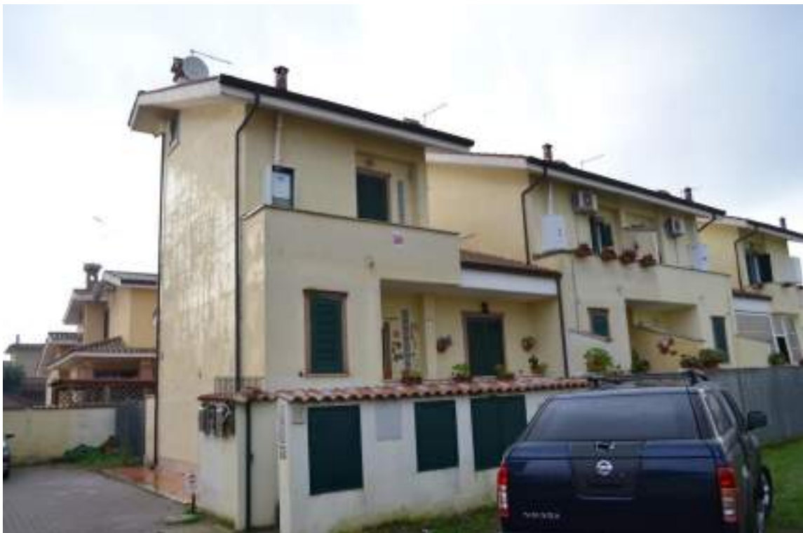
Foto 2: Vista esterna edificio
