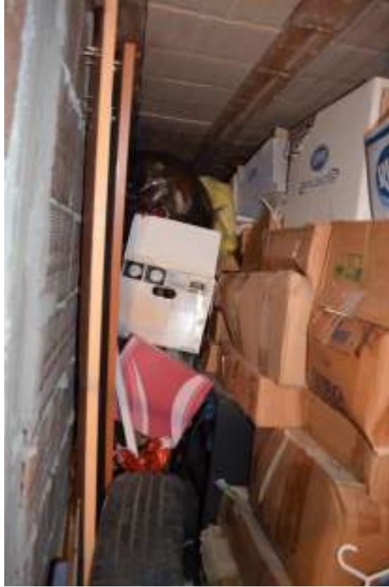
Foto 9 – Lotto 1 Piano Seminterrato: Intercapedine
