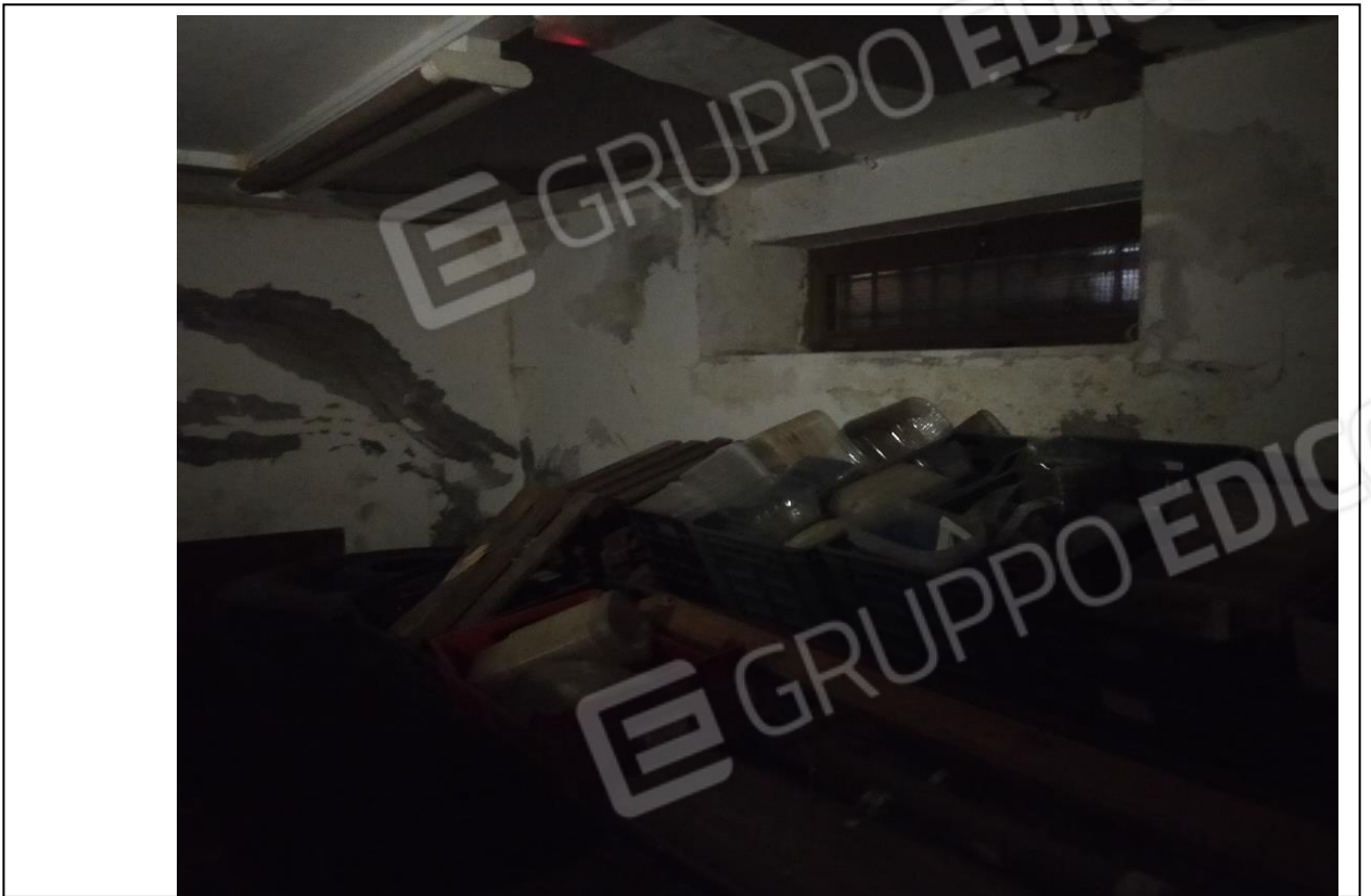
Foto 13 - interno piano interrato
