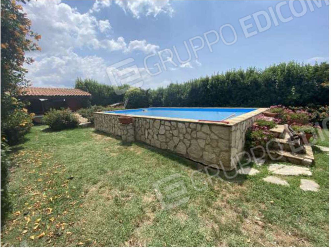
piscina da demolire
