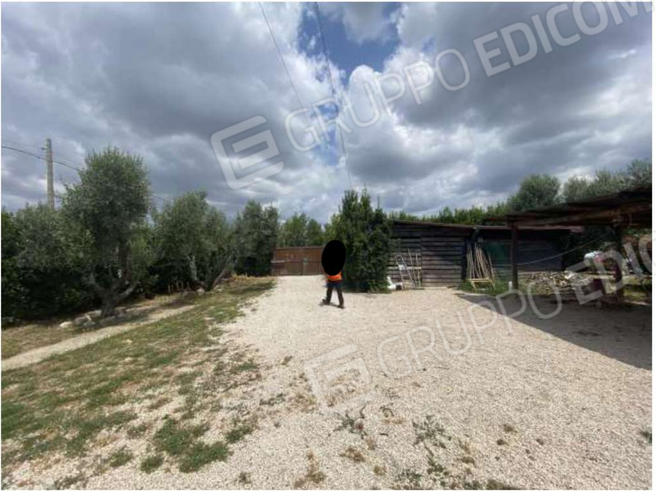
tettoie ed accessori esterni da demolire
