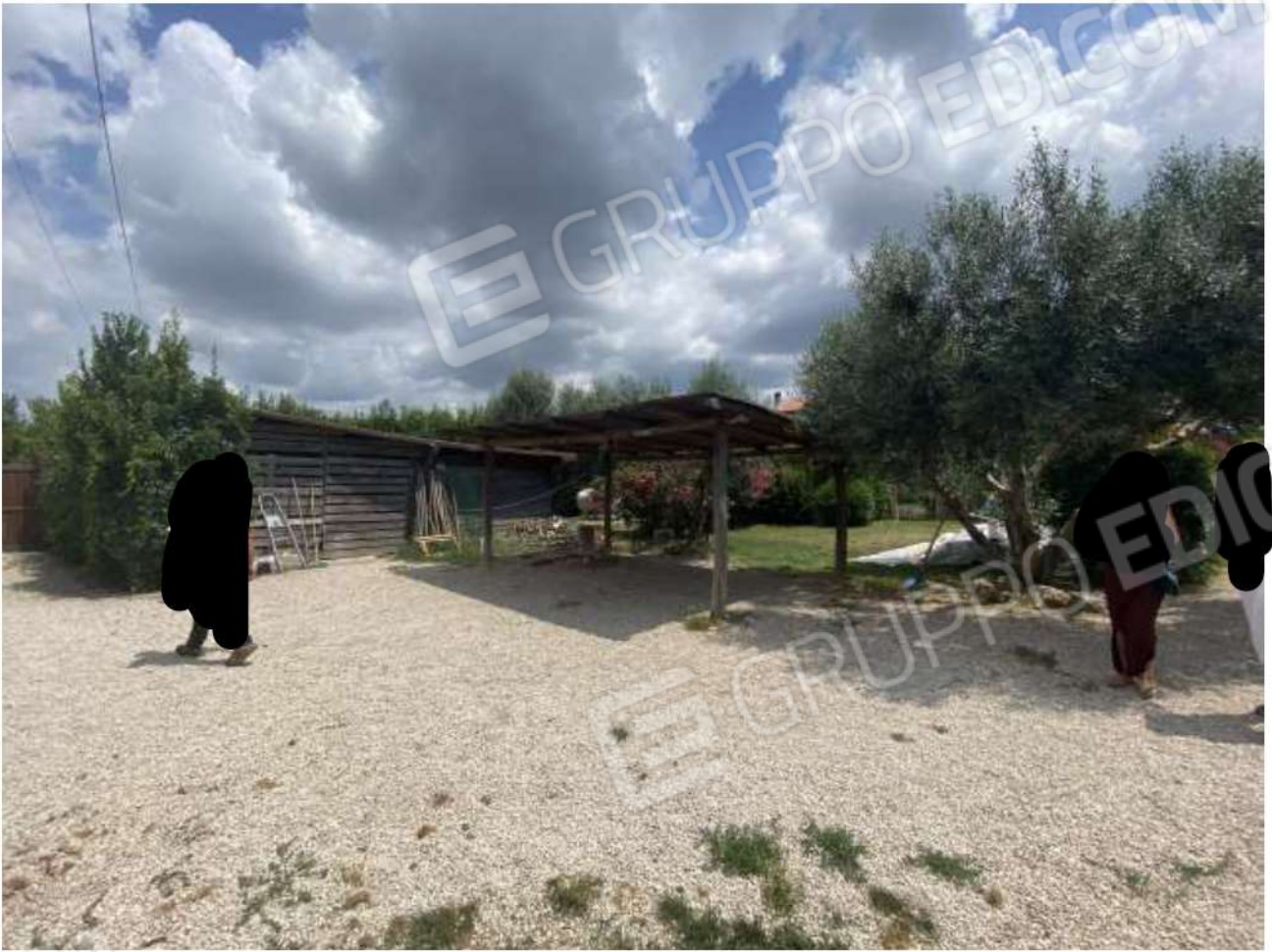
tettoie ed accessori esterni da demolire
