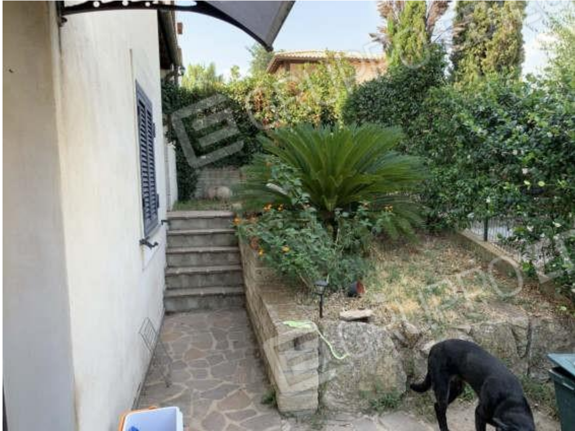
Foto N. 5: Particolare corte esterna lato ingresso
