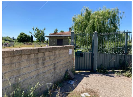
Vista da via della Mainella
