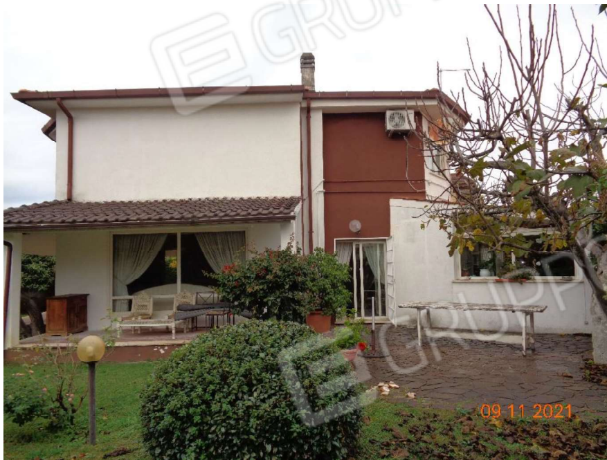
Foto 3 – Vista dalla corte della facciata sud con il portico
