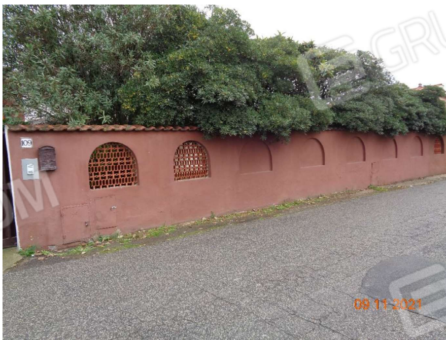
Foto 2 – Vista del muro di cinta lato strada
