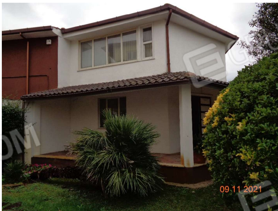
Foto 6 – Vista della facciata nord
