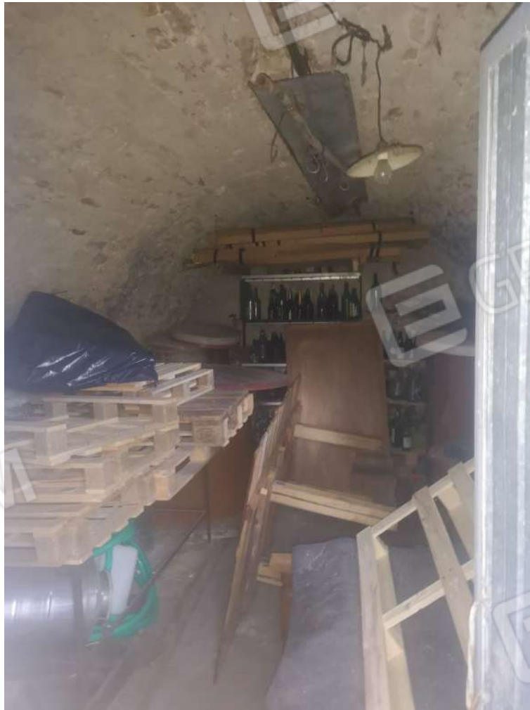
Foto n. 13 - Cantina al piano seminterrato
